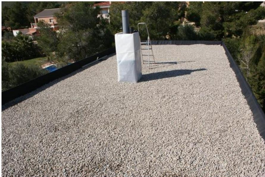
**Ilustración 3: Cubierta impermeabilizada con un acabado de grava**
