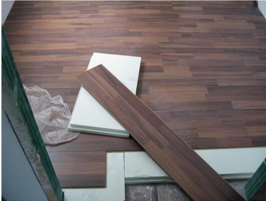
**Ilustración 4: Aplicación de madera laminada en el suelo de los contenedores**
