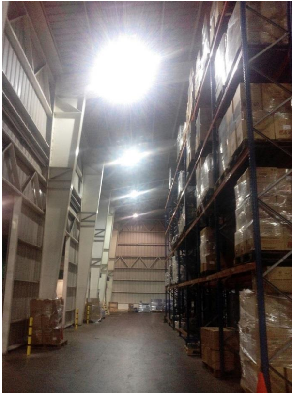
3.- ILUMINACIÓN PERIFERICA CD TEGUCIGALPA
