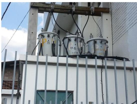
**Figura 15. Banco de transformadores 275 KVA**
