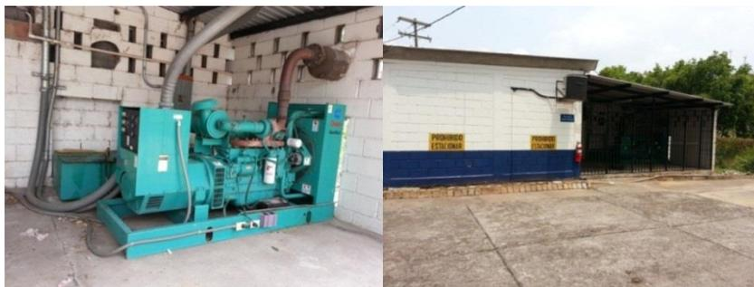
**Figura 17. Motor generador de energía de respaldo**
