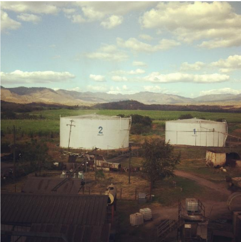
ANEXO 5. Tanques utilizados para el almacenamiento de la melaza fluida
