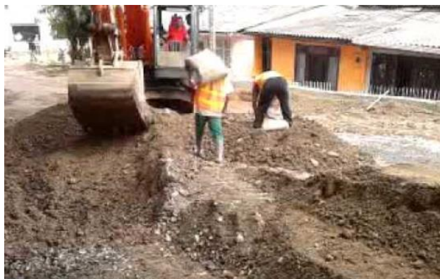
Figura 12. Ejecución de Mezcla Suelo-Cemento
