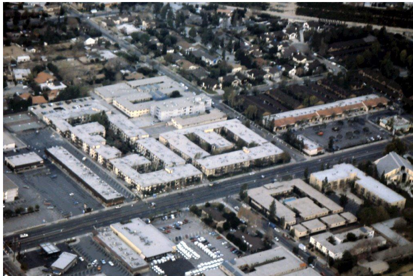
Figura 9: Vista general del complejo de apartamentos Northdrige Meadows.
