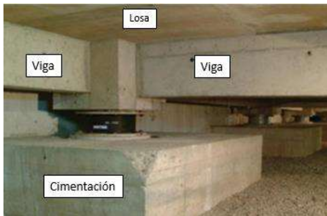
Ilustración 10 Sistema de aislación basal.
