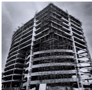
Figura 1. Construcción Torre Futura, Col. Palmira, Tegucigalpa, MDC.
