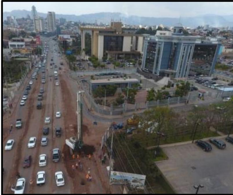
**Figura 7. Perforación de pilotes túnel Bulevar Centroamérica.**
