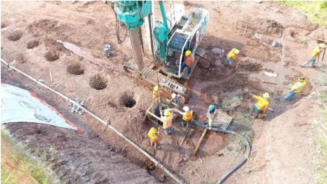
**Figura 1. Proceso constructivo para excavación de pilotes.**
