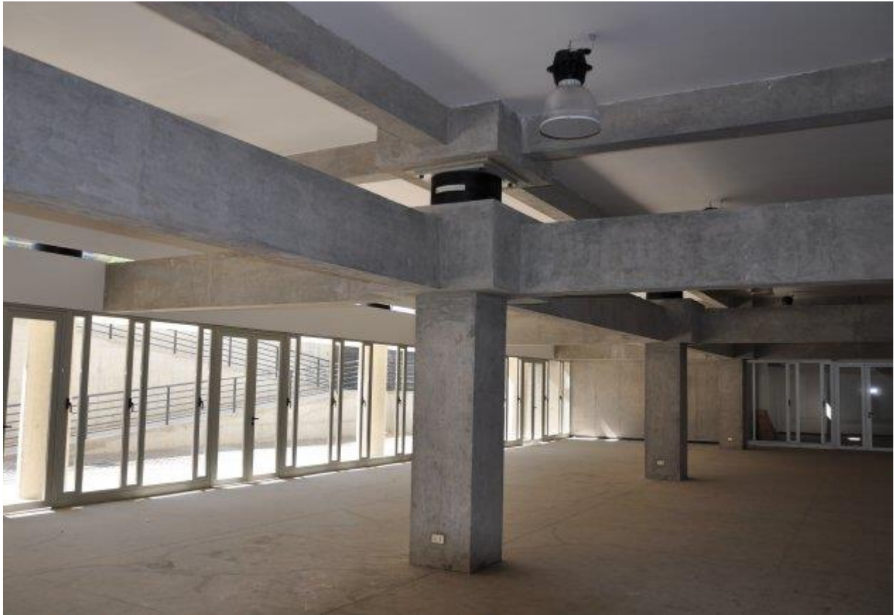
Figura 71. Aisladores de base colocados como apoyos del nivel de aislamiento
