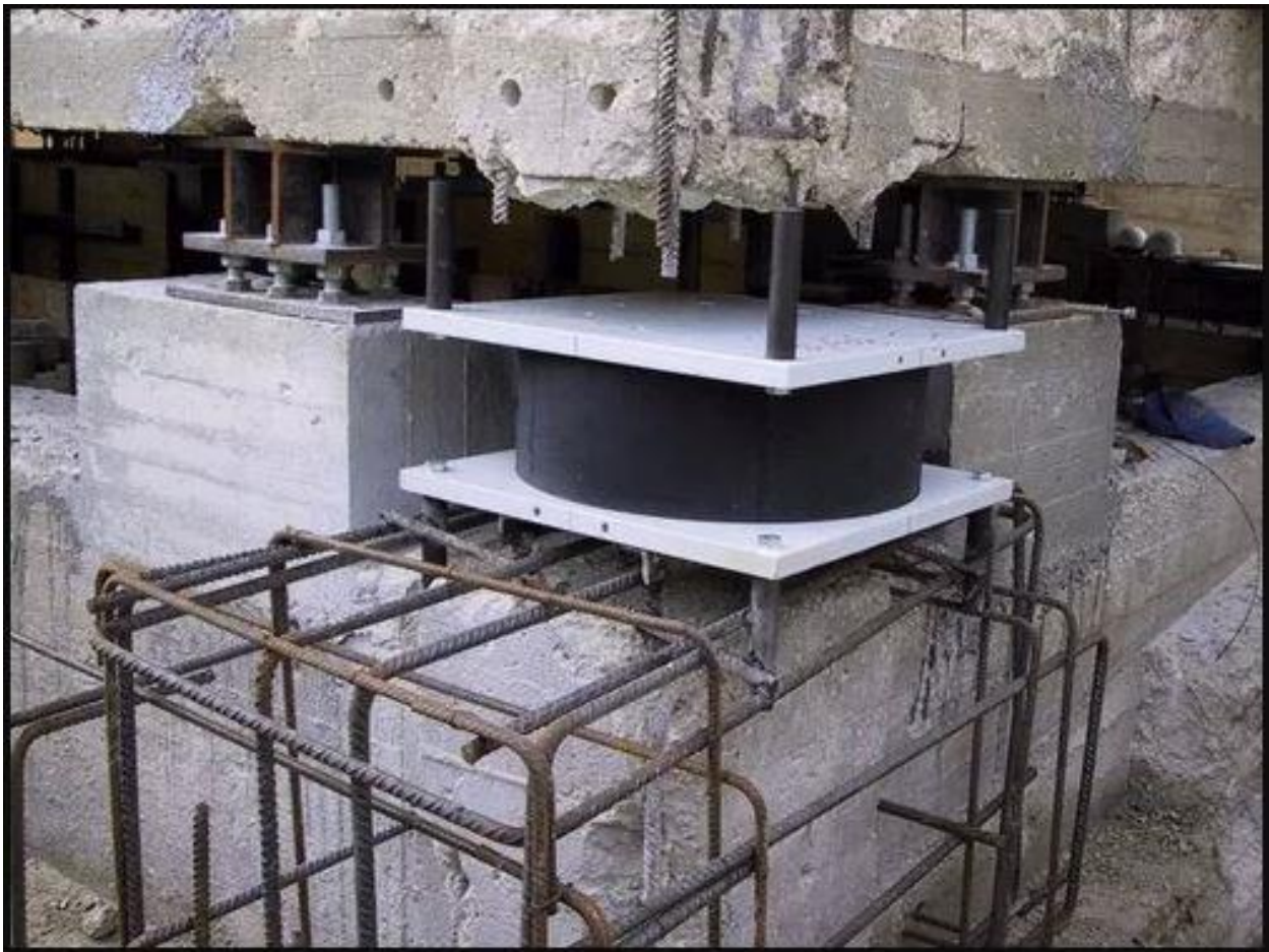
Figura 73. Instalación de aisladores de base como refuerzo en estructuras existentes
