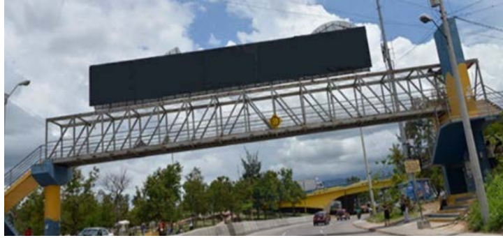
Figura 3. Puente Peatonal con estructura reticular mixta
