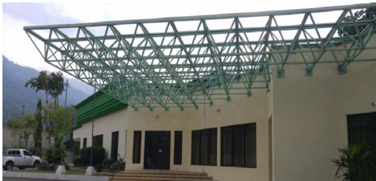
Figura 5. Estructura espacial reticular como cubierta de techo en voladizo.
