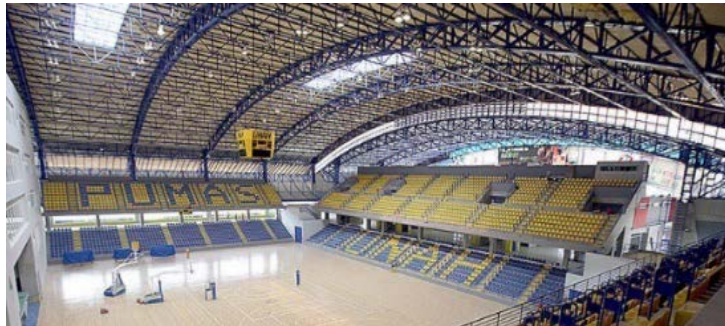
Figura 4. Estructura espacial reticular como cubierta de techo.
