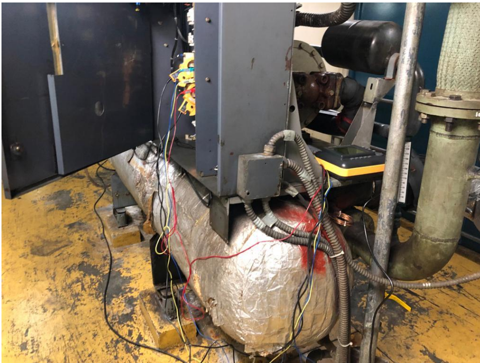
Fuente: Instalaciones de CHFM.
