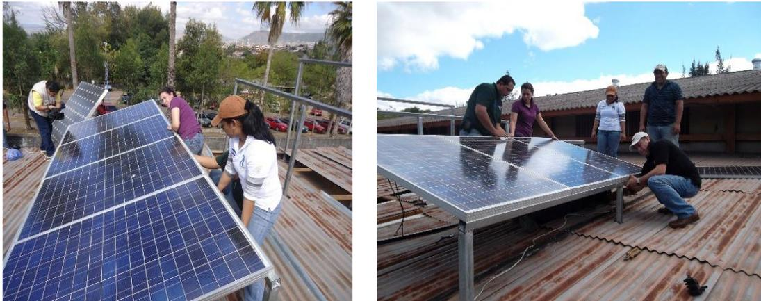
**Figura 11: Instalación PV en el techo del edificio UNAH**
