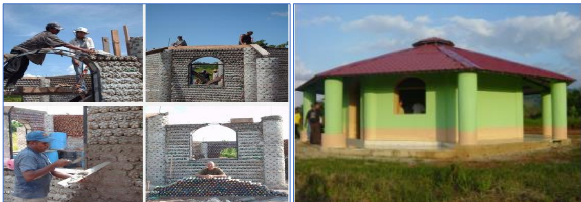
Figura 8. Construcción con la tecnología Ecotec.
