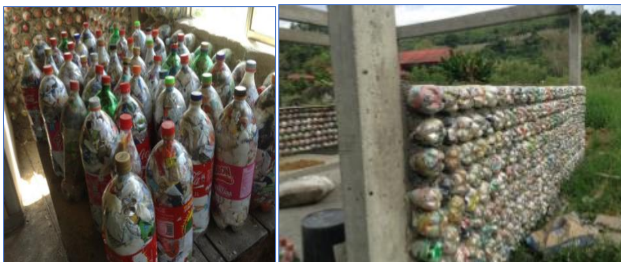
Figura 18: Ecoladrillos y su organización estructural al construir.
