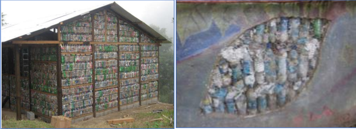
Figura 9. Construcción con ecoladrillos.
