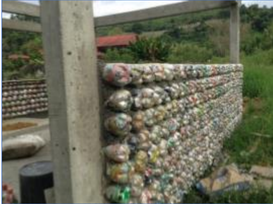
Figura 20. Levantamiento de muros.
