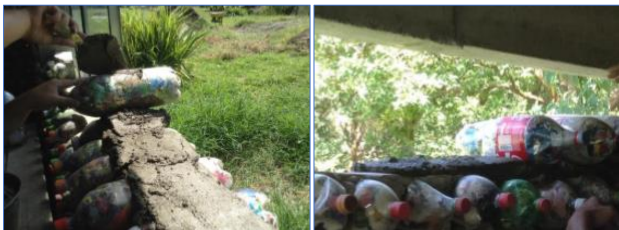
Figura 19. Pegado de ecoladrillos.
