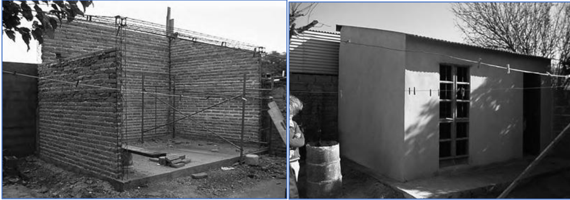
Figura 6. Construcción con la tecnología CEVE en Córdoba, Argentina.
