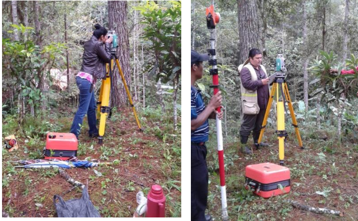
levantamiento topográfico para línea de conducción y línea de transmisión
