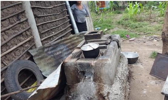
Fotografía No. 9 y 10: Estufas con modificaciones que alteran su funcionamiento, por destrucción de cámara de combustión y la chimenea.
