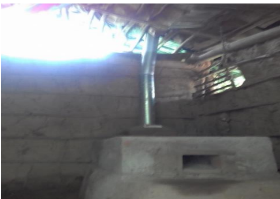
Fotografía No.11 y 12: Estufas en desuso por techo dañado y corrosión en chimenea.
