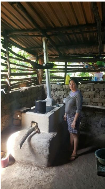
Fotografía No.11, 12 y 13: Estufas mejoradas construidas en los hogares que participaron en la evaluación del consumo de leña a través de la prueba KPT.
