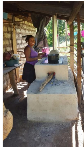
Fotografía No.11, 12 y 13: Estufas mejoradas construidas en los hogares que participaron en la evaluación del consumo de leña a través de la prueba KPT.
