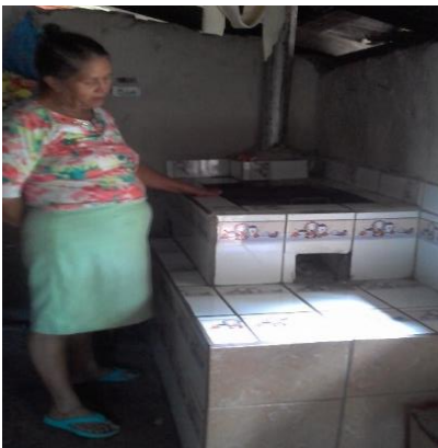
Fotografía No. 5 y 6: Estufas con modificaciones que no alteran su funcionamiento, por agregados de cerámica en el exterior.
