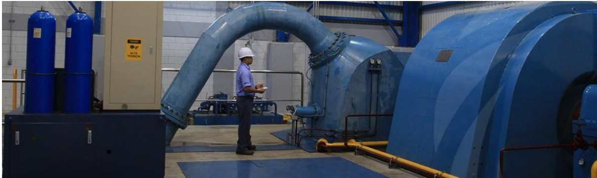
Figura 17. Casa de Máquinas Hidroeléctrica San Juan
