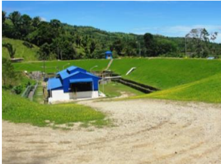
Figura 3. Casa de Máquinas Planta La Gloria
