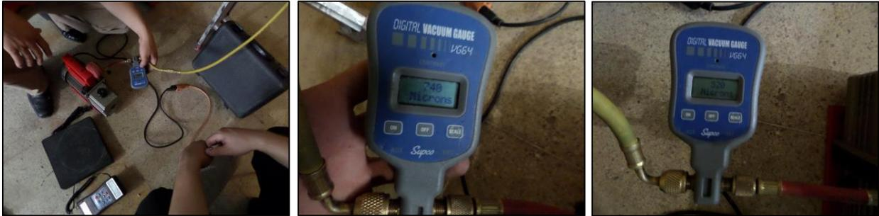
**Figura 15. Proceso de vacío del equipo.**
