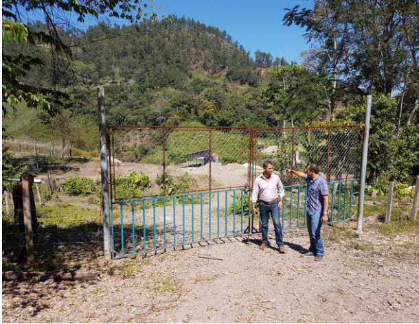
Ilustración 16. Acceso a canales de conducción
