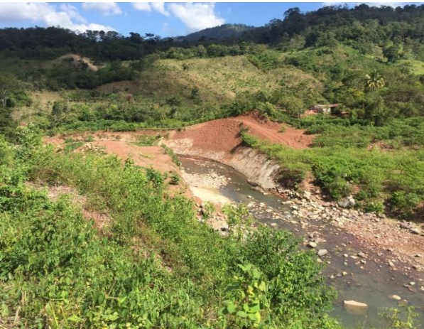
Ilustración 14. Obra civil para estabilización de erosión
