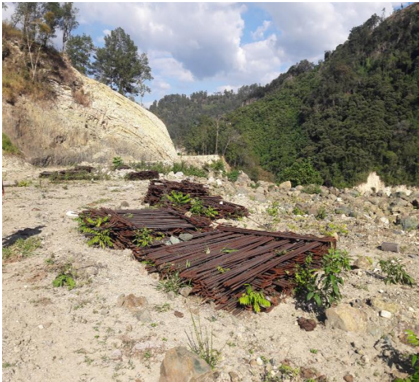
Ilustración 18. Varilla apilada para construcción
