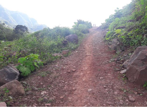
Ilustración 12. Calles de acceso deterioradas
