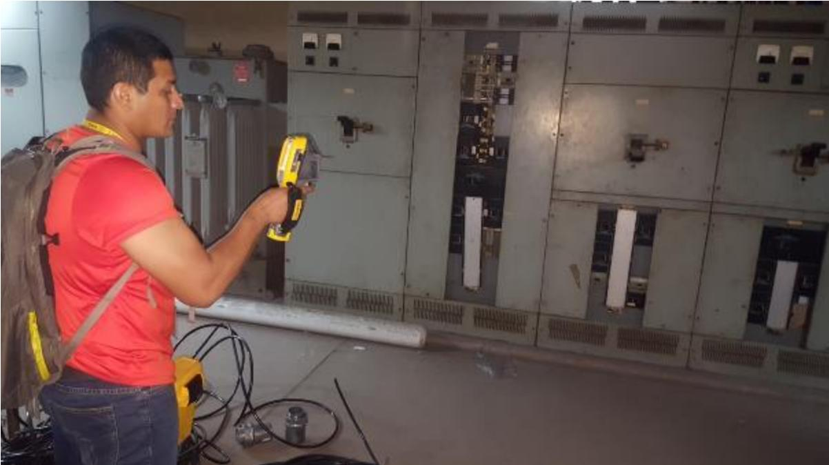
**Figura A 4 Toma de temperatura con cámara termográfica en subestación, 2017**
