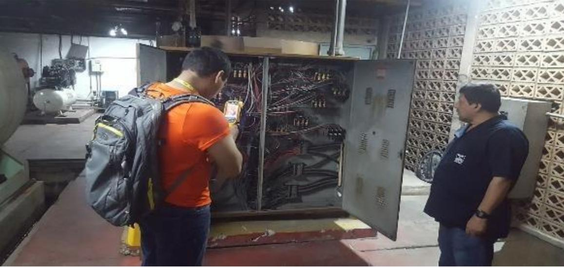
**Figura A 3 Toma de temperatura con cámara termográfica en gabinete de control, 2017**
