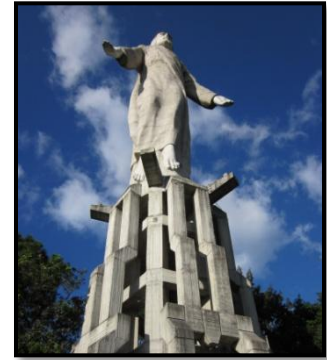
Figura 13. Vista del Cristo dentro del predio del MCP.
