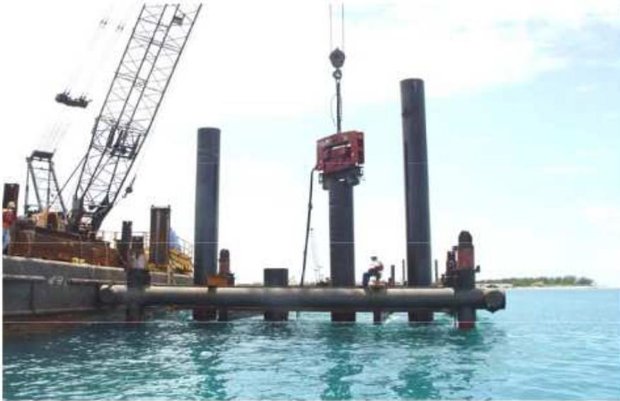
Figura 30. En la imagen se observa el hincado de las cimbras metálicas para fundición de columnas o pilotes.
