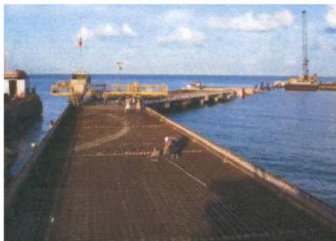
Figura 34. Ejemplo de colocación de armado para fundición de losa
