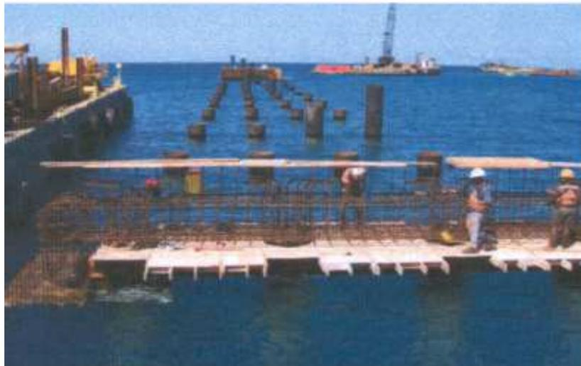
Figura 33. Ejemplo de colocacion de traveses para soporte
