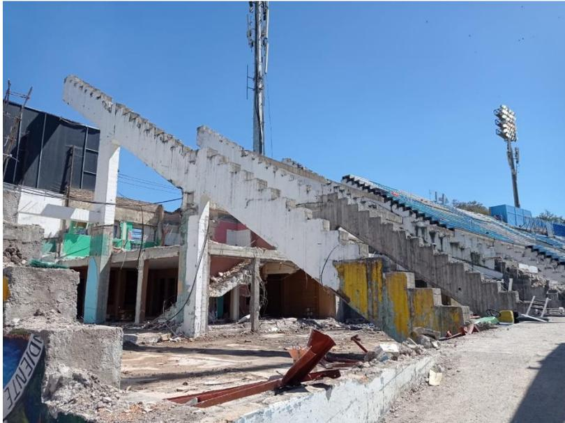
**Ilustración 61 - Vigas serruchos correspondientes a ejes que requieren demolición.**
