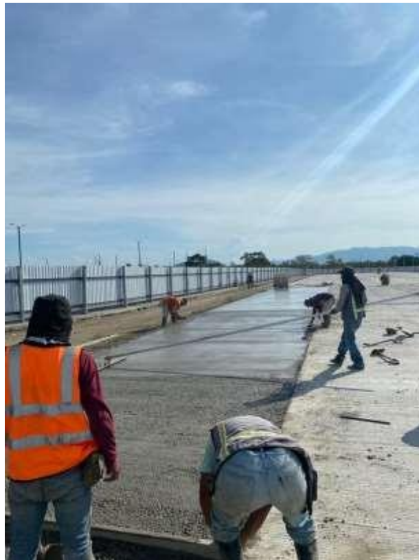
Ilustración 4- Fundición de tramo #6
