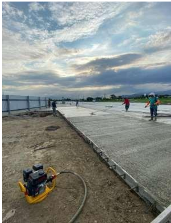
Ilustración 7- Nivelado y Rastrillado del concreto fresco
