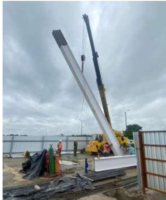
Ilustración 17- Montaje de estructuras metálicas
