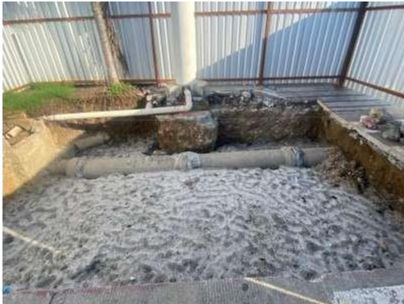
Ilustración 10- Colocación de piedra bola y arena de río
