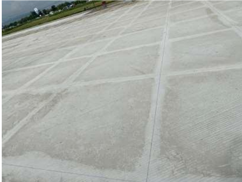
Ilustración 13- Sellado de juntas con R12B
