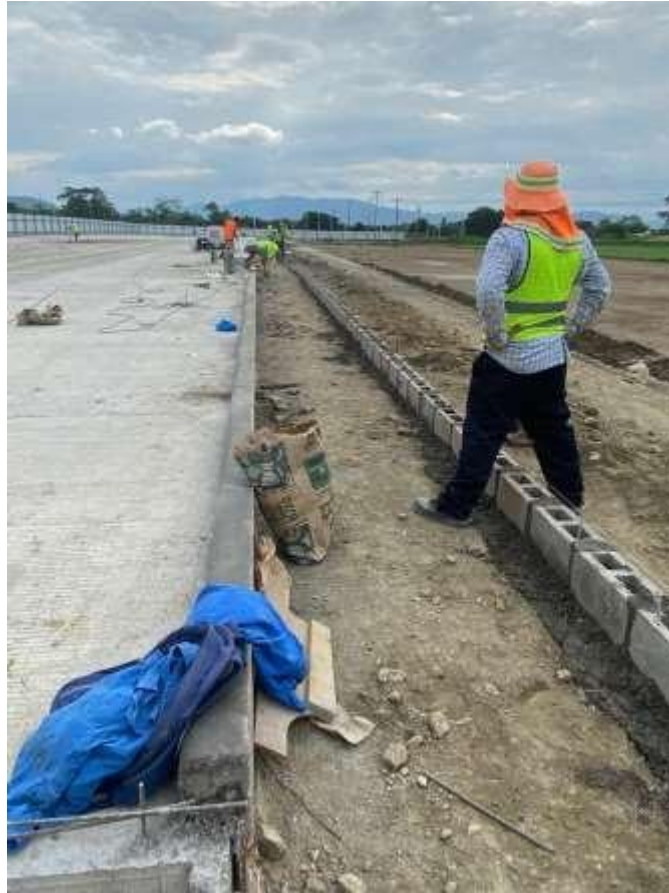
Ilustración 9- Inicio de construcción de aceras y bordillos
