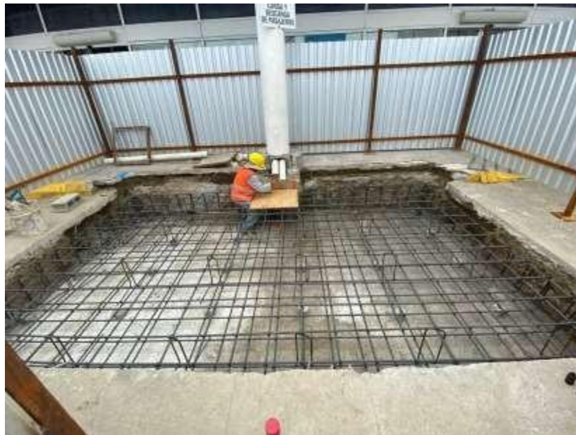
Ilustración 12- Armado de acero en zapatas Z-2
