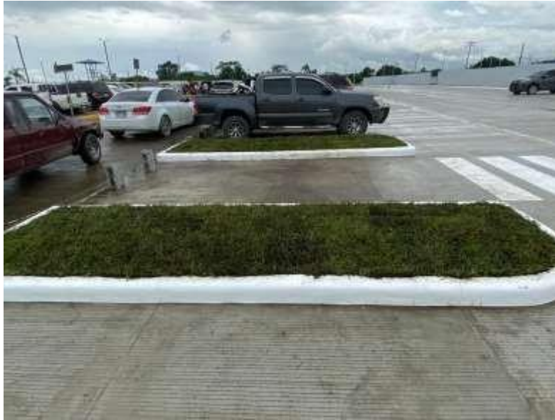
Ilustración 18- Colocación de grama es islas
