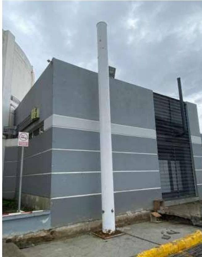
Ilustración 22- Montaje de columna circular
