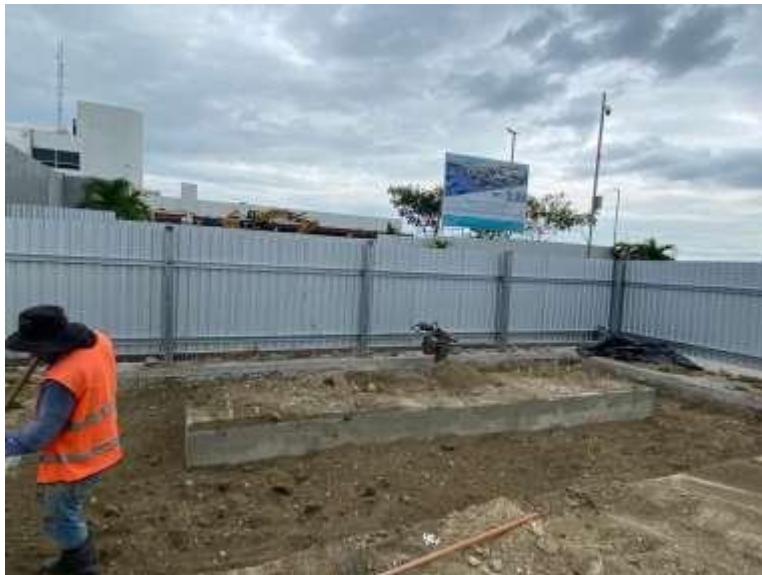
Ilustración 8- Relleno con material selecto en Z-1
