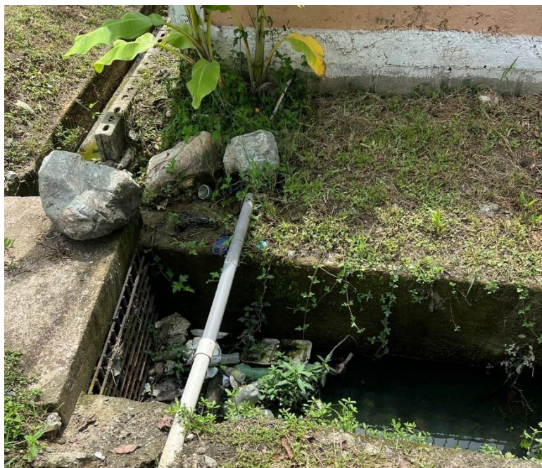
Ilustración 21-Canal de Concreto Abierto existente
