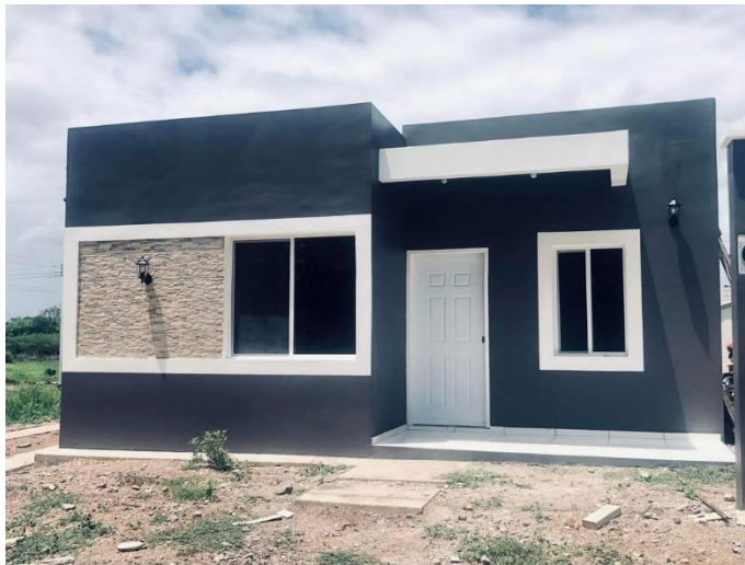
Figura 38. Vivienda más económica de la constructora Honterra
