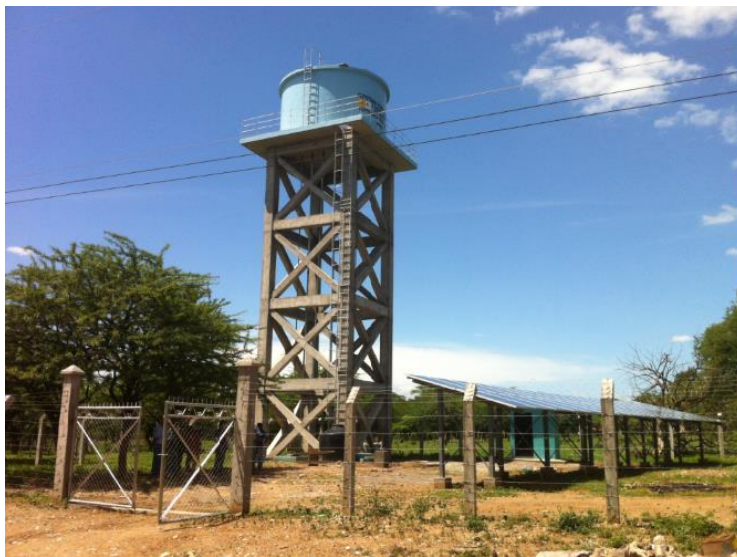
Figura 10. Sistema de agua con paneles solares
