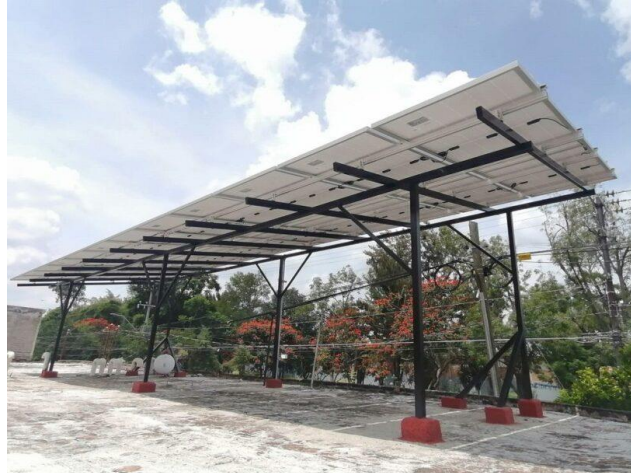
Figura 11. Estructura metálica reforzada
