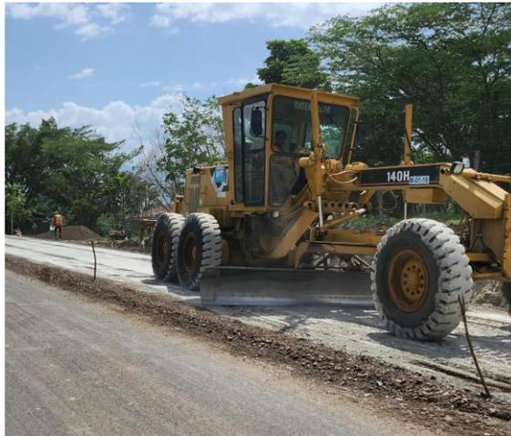
**Ilustración 48 Motoniveladora en proceso de afinamiento**
