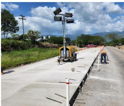
**Ilustración 41 Carpeta de concreto hidráulico sobre residuo de doble tratamiento asfáltico**
