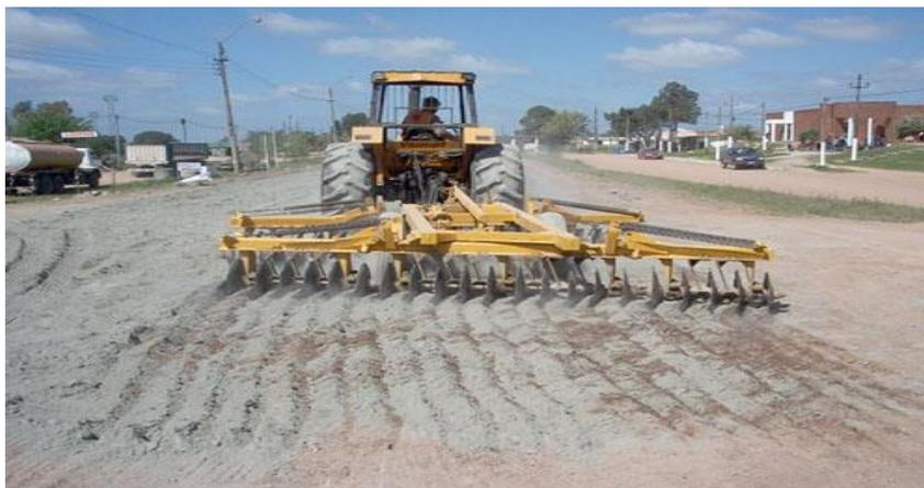
**Ilustración 36 Estabilización de suelos con cemento**
