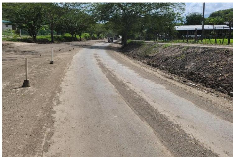
**Ilustración 55 Capa de arena sobre la imprimación**
