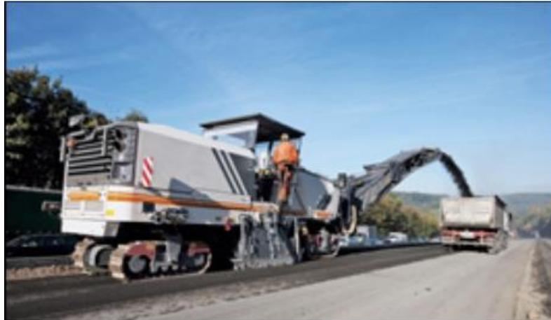
**Ilustración 37 Obtención del RAP por fresado.**
