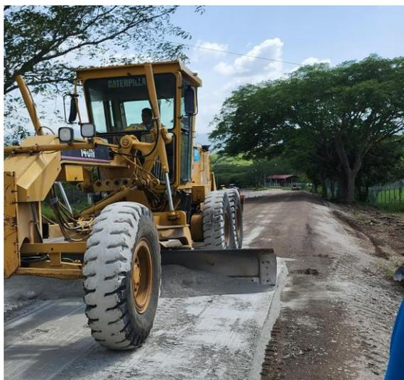
**Ilustración 46 Tendido de cemento utilizando motoniveladora**
