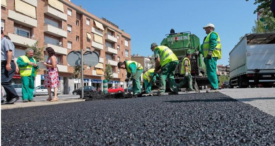
**Ilustración 8 Doble tratamiento asfáltico**
