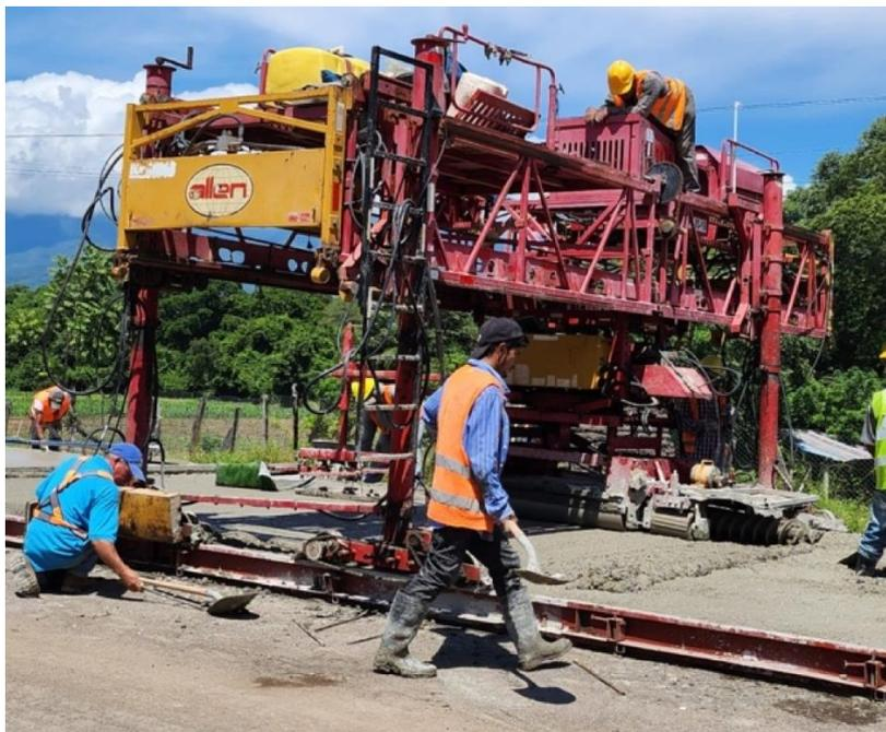
**Ilustración 56 Pavimentadora**
