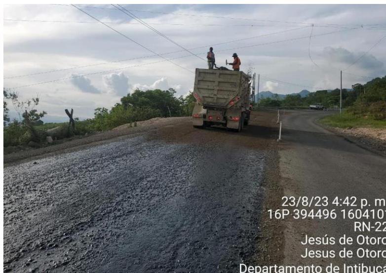
**Ilustración 54 Aplicación de capa de arena sobre imprimación**
