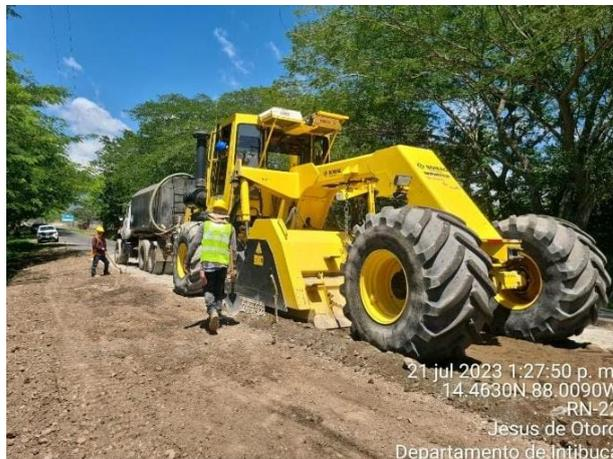
**Ilustración 47 Mezcla de residuo de asfalto y suelo estabilizado con cemento por medio de recicladora anclada a camión cisterna**
