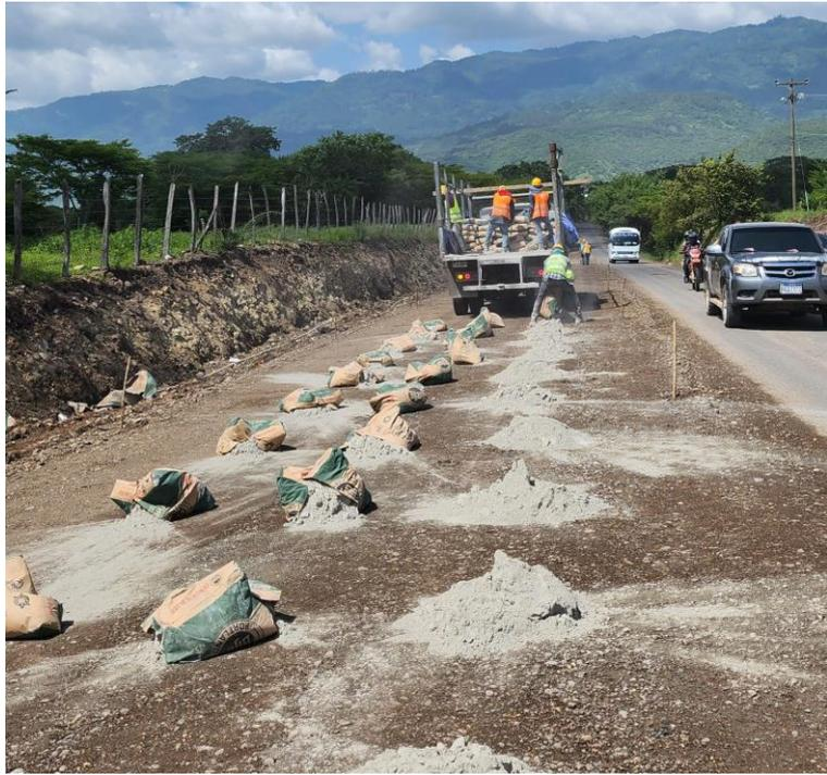
**Ilustración 44 Colocación de cemento en bolsas**
