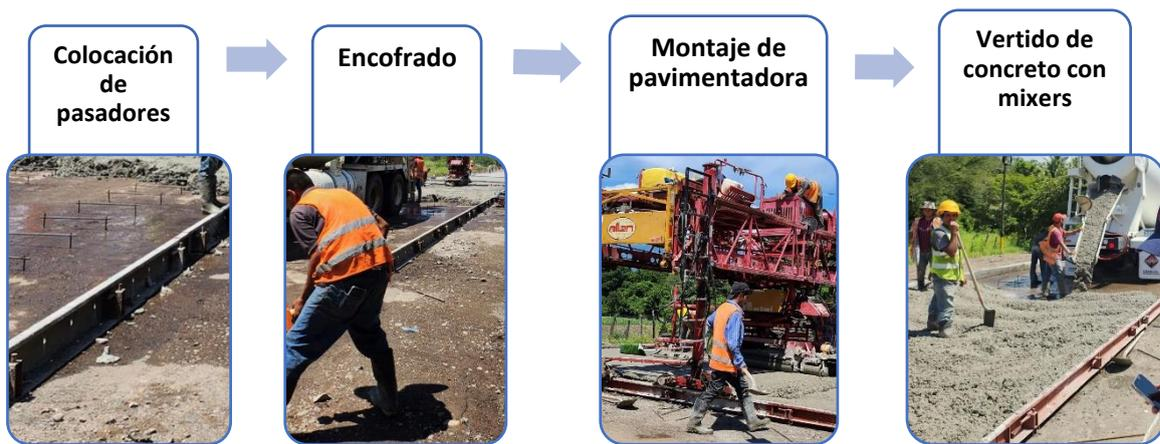
**Gráfico 14 Etapas para la colocación del concreto hidráulico 1**
