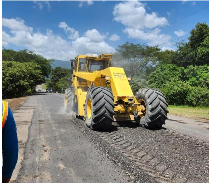
**Ilustración 42 Maquinaria de escarificar, mezclado y reciclado.**
