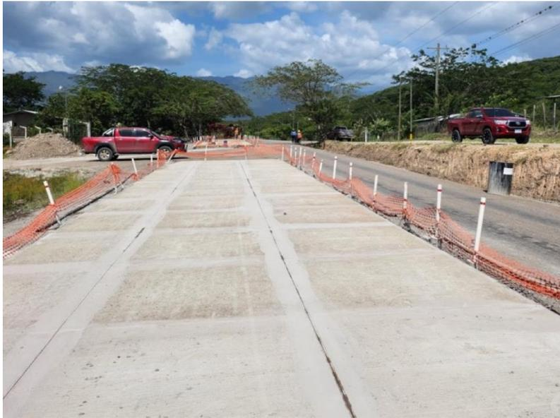
**Ilustración 59 Carpeta de concreto hidráulico**
