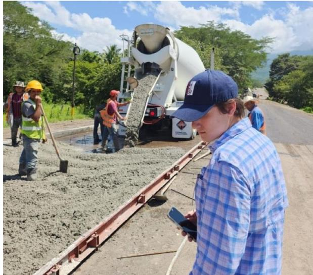
**Ilustración 57 Vertido de concreto**
