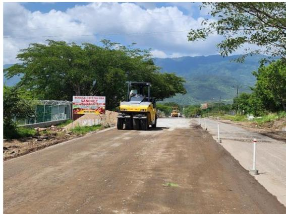
**Ilustración 49 Compactador neumático en proceso de compactación**
