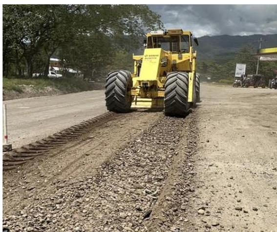
**Ilustración 60** Uso del RAP como elemento de la subbase
