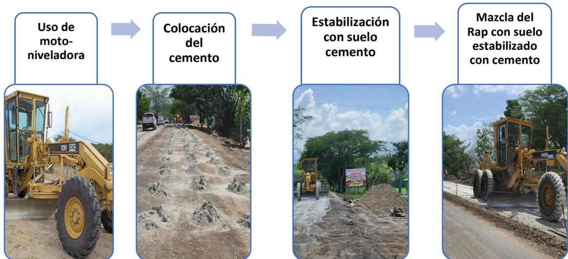
**Gráfico 12 Mezcla del RAP con suelo estabilizado con cemento**
