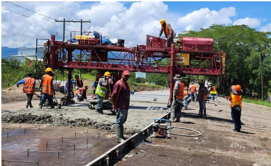
**Ilustración 58 Esparcimiento y vibrado del concreto**
