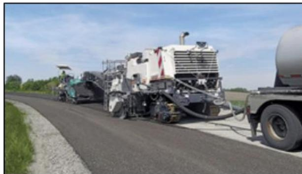
**Ilustración 38. Obtención del RAP por reciclado.**
