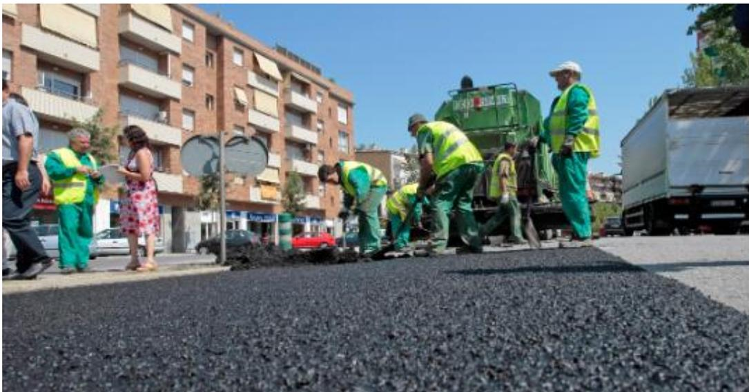
**Ilustración 1 Reciclaje de doble tratamiento asfáltico**
