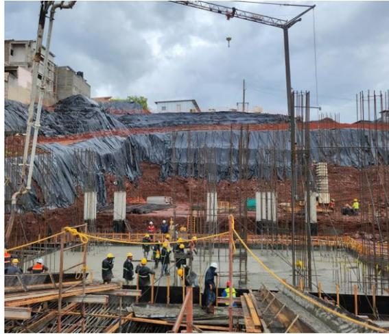
**Ilustración 11. Losa de cimentación Tramo 1, Lirios de Miraflores**
