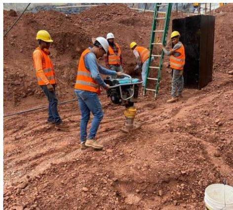
**Ilustración 10. Compactación de cimentación en torre Lirios de Miraflores**
