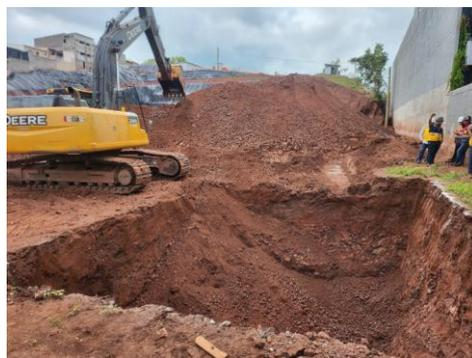
**Ilustración 9. Excavación para cimentación en torre Lirios de Miraflores**
