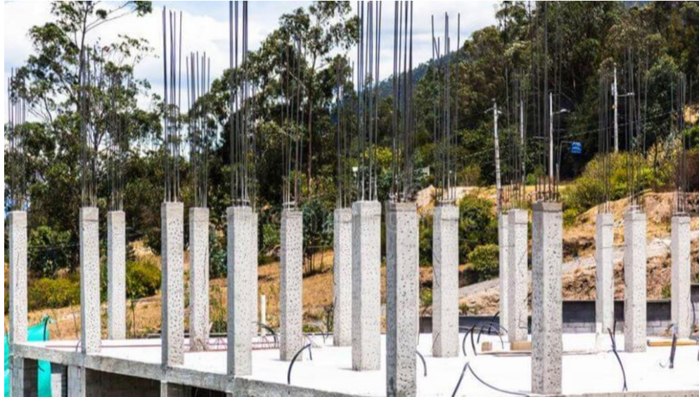
Ilustración 13. Columnas de concreto
