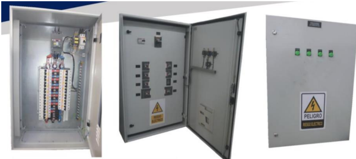
Ilustración 18. Tableros de distribución
