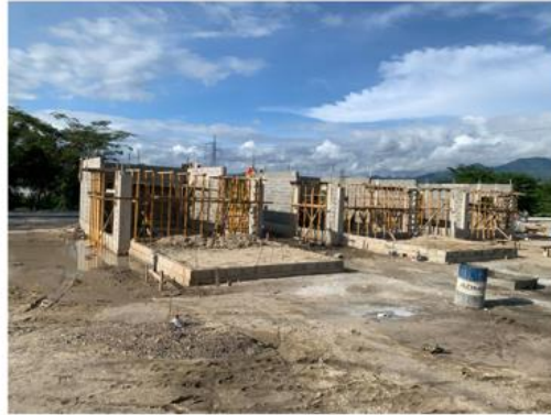
Ilustración 6. Armado de pilotes.
