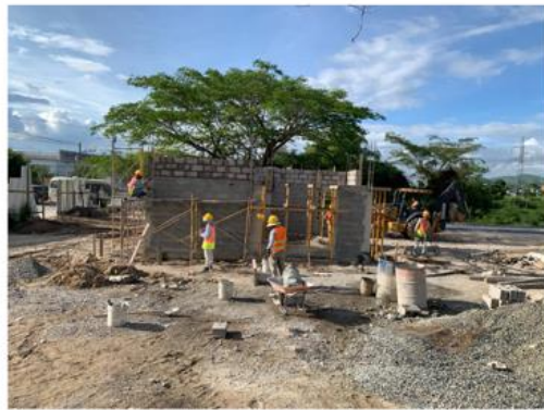
Ilustración 7. Levantamiento de 3 hiladas restantes en ultimo autoservicio.
