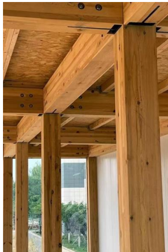
Ilustración 12. Columna de madera
