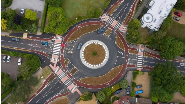
Ilustración 60. Cruce peatonal en rotondas
