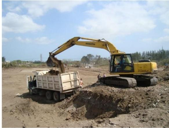
**Ilustración 15. Ejemplo de acarreo de material**
