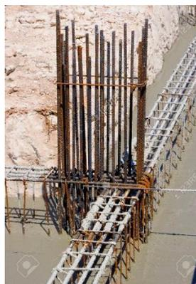
**Ilustración 35. Construcción de viga tensora**
