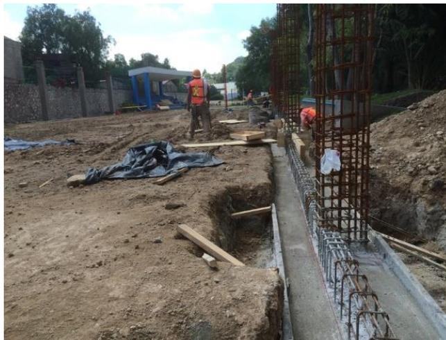
**Ilustración 33. Construcción de zapata corrida**
