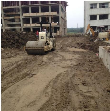
**Ilustración 19. Ejemplo de compactación con rodillo vibratorio**
