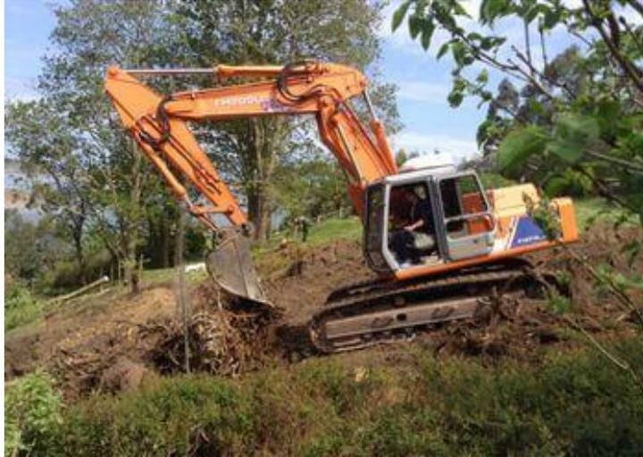
**Ilustración 17. Ejemplo de despeje y desbroce**
