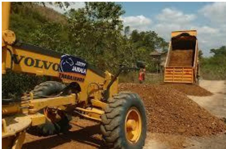
**Ilustración 21. Ejemplo de construcción de subbase**
