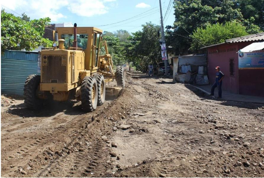
**Ilustración 20. Ejemplo de conformación de calle**
