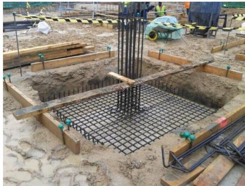
**Ilustración 29. Construcción de zapata aislada**
