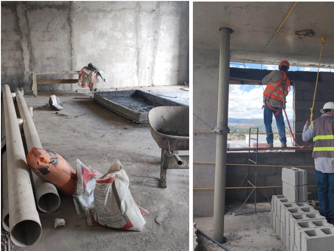
Ilustración 102. Recorrido de obra de albañilería en TS.
