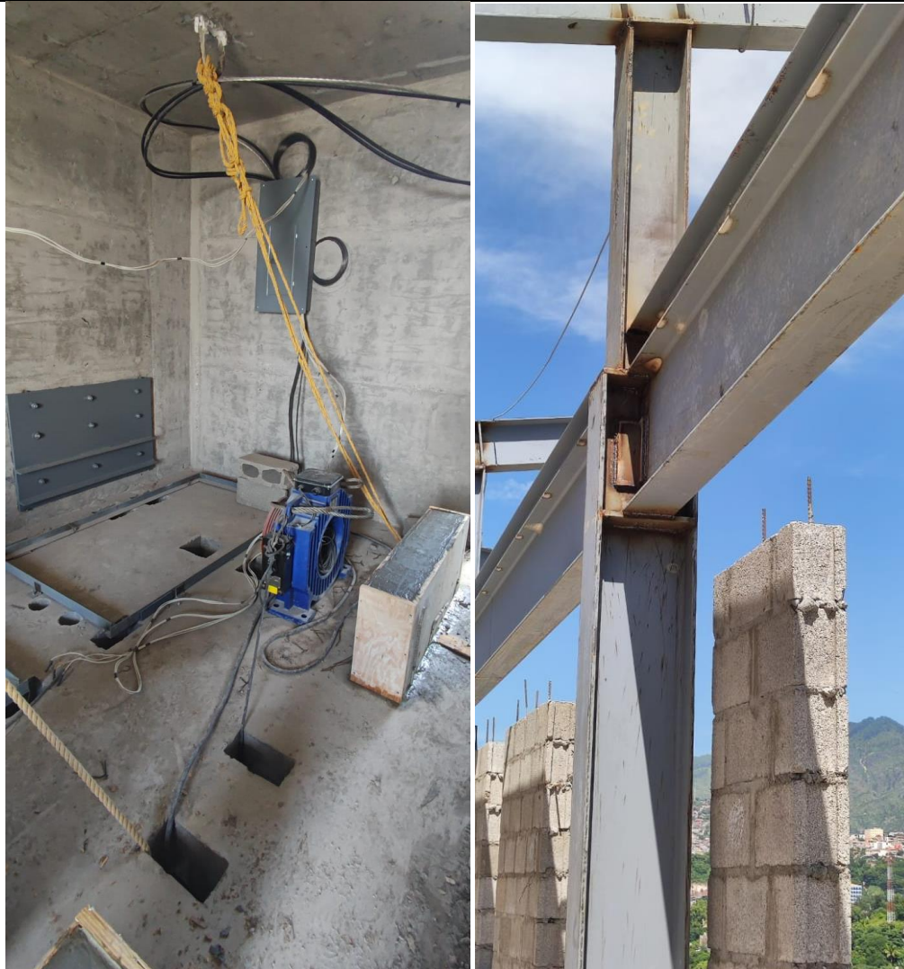
Ilustración 62. Sala de máquinas y armado de perfiles metálicos
