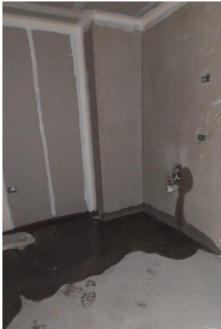
Ilustración 52. Fuga de agua en Apto. 6 N11 y cálculos de rendimientos de asfalto
