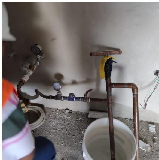
Ilustración 49. Prueba hidrostática suspendida
