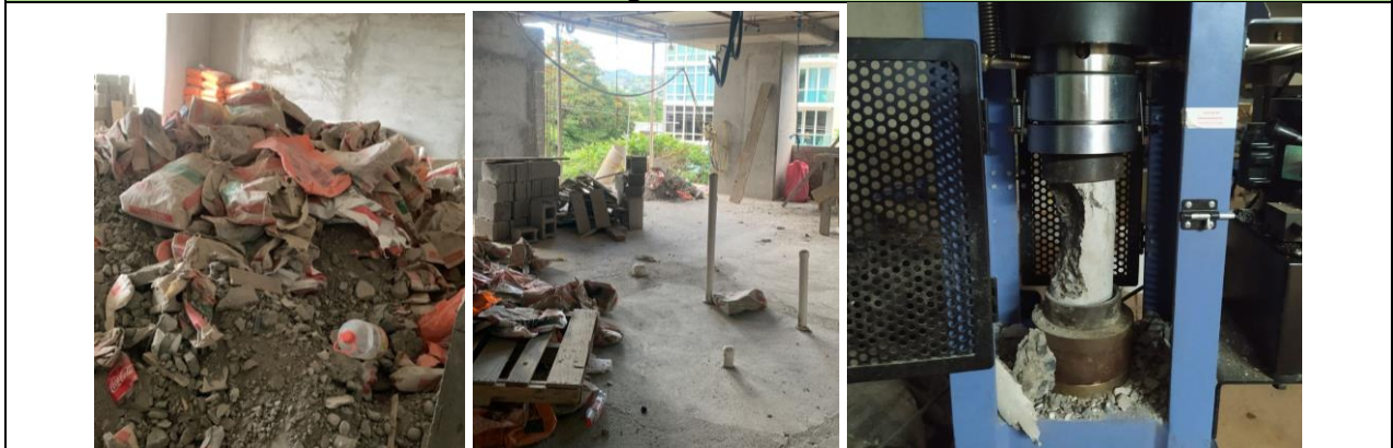
Ilustración 59. Limpieza del nivel 4 torre sur y pruebas a compresión de cilindros
