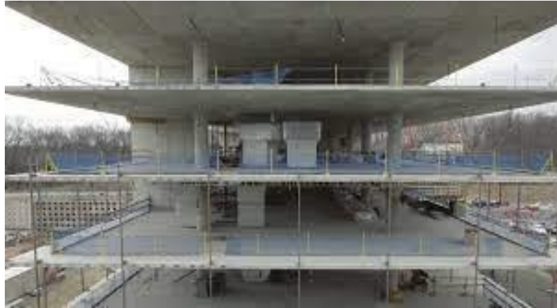
Ilustración 39. Losas y columnas postensadas
