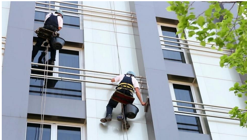
Ilustración 35. Mantenimiento de edificios, exteriores
