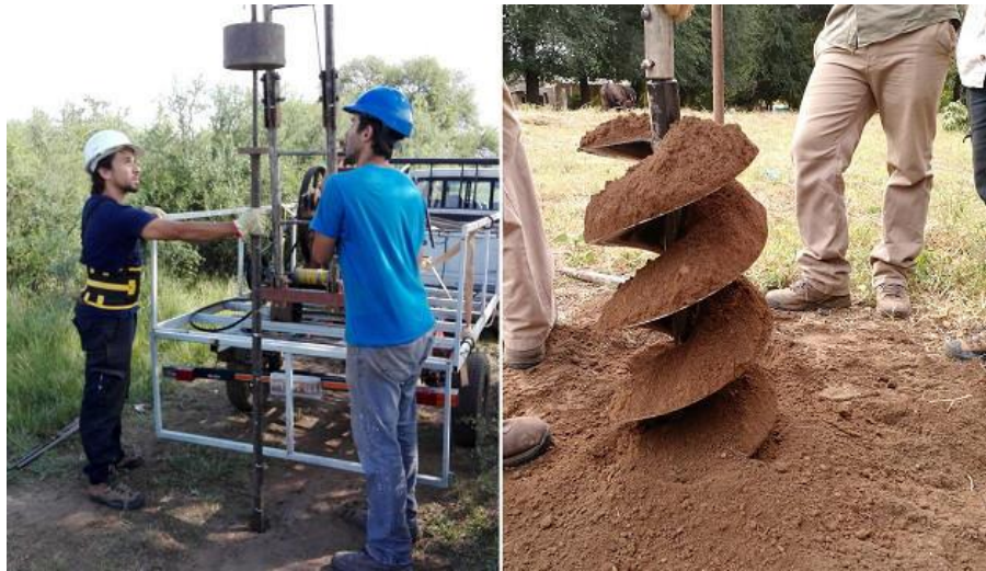
Ilustración 20. Estudios de suelos para un proyecto constructivo
