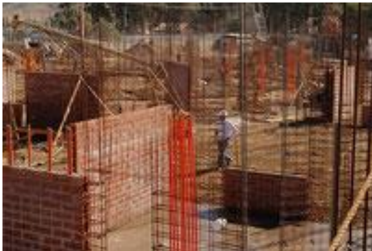
Ilustración 23. Albañilería reforzada o confinada
