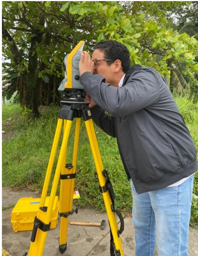
**Ilustración 131- Levantamiento topográfico mediante Trimble C5**
