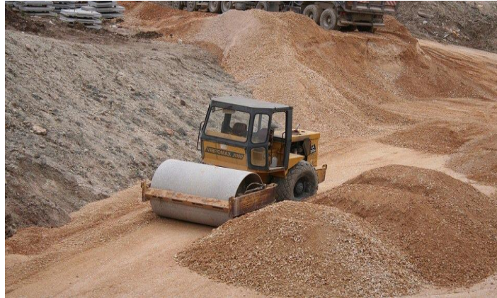
Ilustración 13 Estabilización por compactación
