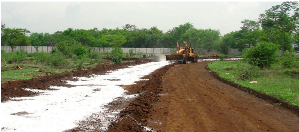
Ilustración 12 Estabilización de suelos
