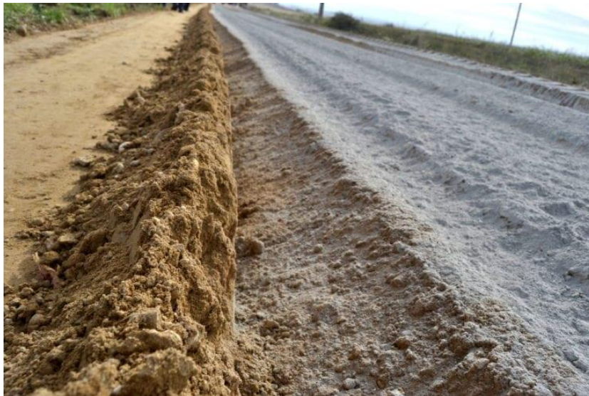
Ilustración 1 Estabilización de suelos
