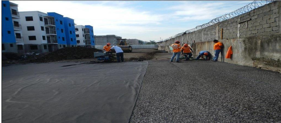
Ilustración 17 Estabilización de suelos con geomalla
