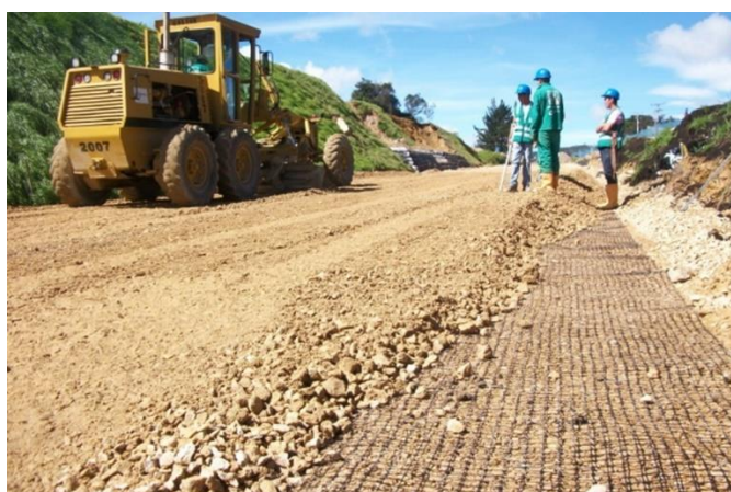
Ilustración 14 Estabilización con reemplazo de material
