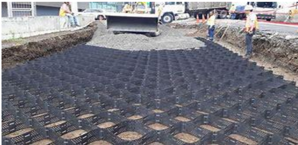
Ilustración 16 Estabilización de suelos con geo celdas
