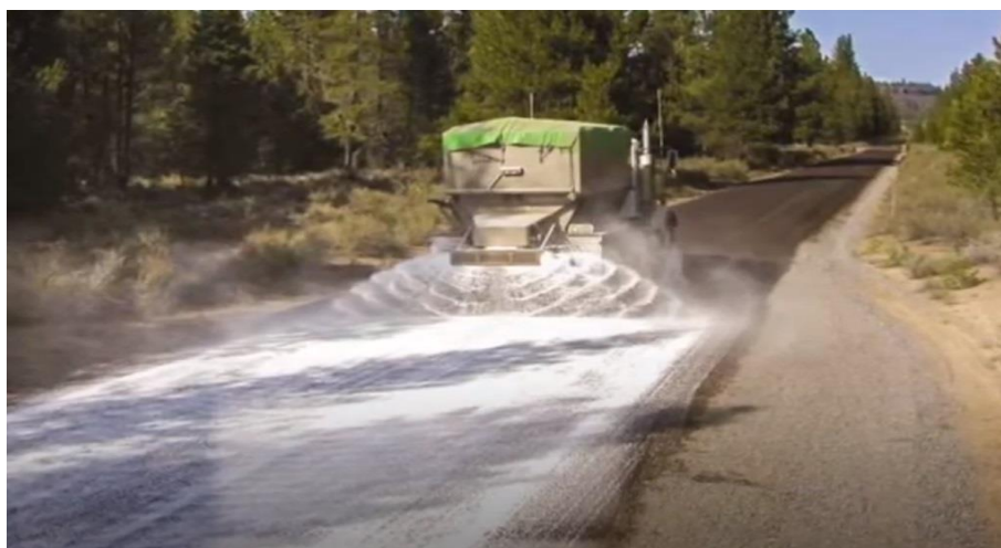
Ilustración 22 Estabilización de suelos con cloruros
