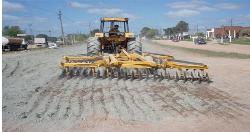
Ilustración 21 Estabilización de suelos con cemento
