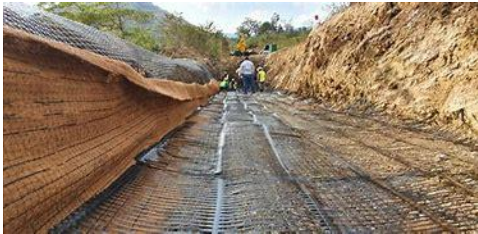
Ilustración 15 Estabilización de suelo con geotextiles
