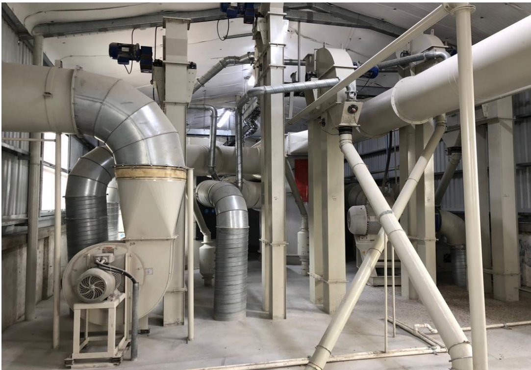
Ilustración 20. Ventiladores de filtros de transporte neumático
