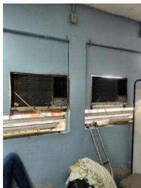
Ilustración 25. Aires acondicionados de rejilla de ventana en Hospitalización de Cirugía
