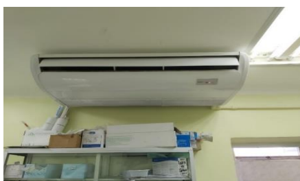
Ilustración 21. Minisplit de 60,000 BTU en Quirófano de Cirugía Laparoscópica
