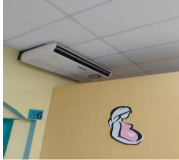
Ilustración 22. Minisplit de 60,000 BTU en Labor y Parto
