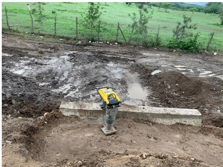
**Ilustración 81 Compactación de suelo en el cabezal de entrada estación 31+533**
