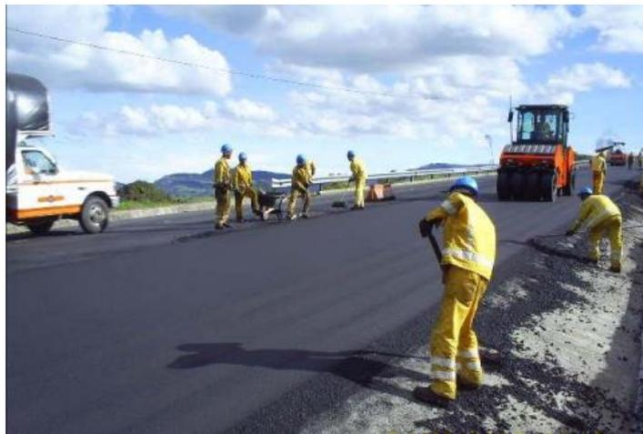
**Ilustración 15 Obras complementarias, refuerzo de la carpeta asfáltica**
