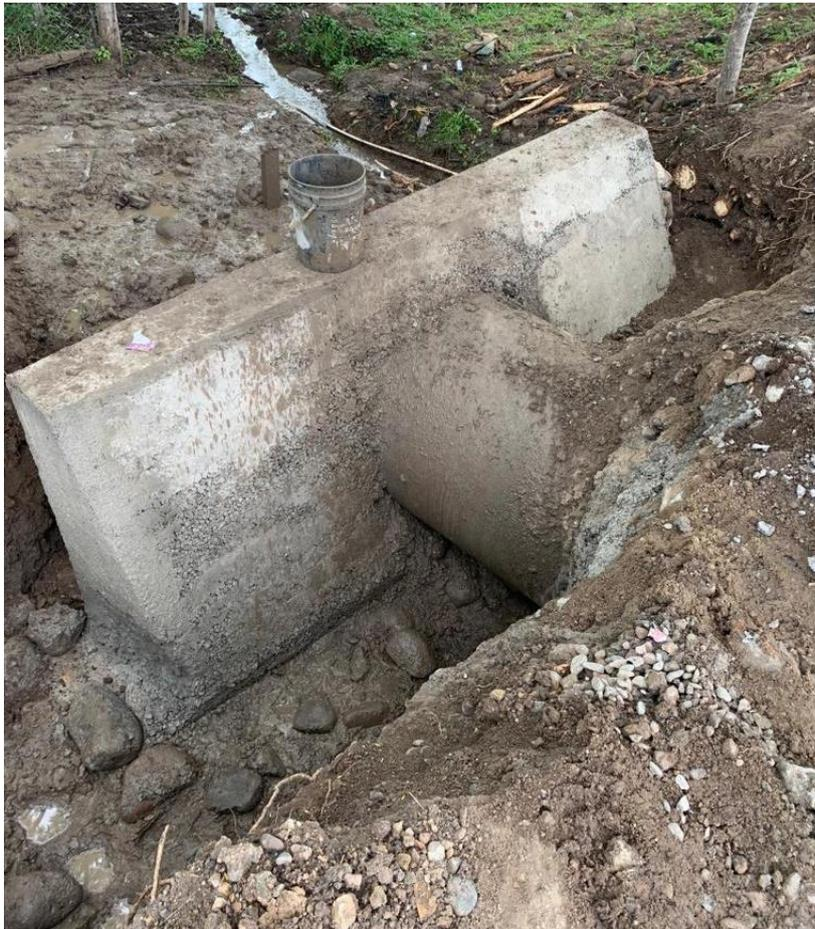
**Ilustración 75 Aterrado de cabezal**
