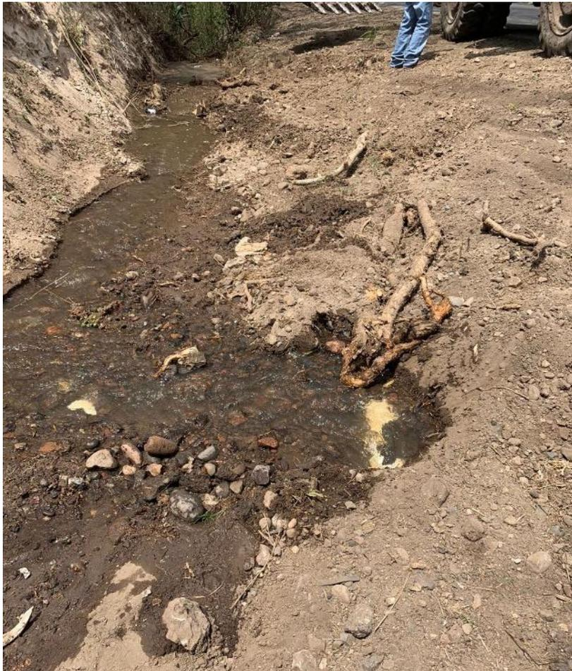
**Ilustración 48 Tubería dañada por la motoniveladora**
