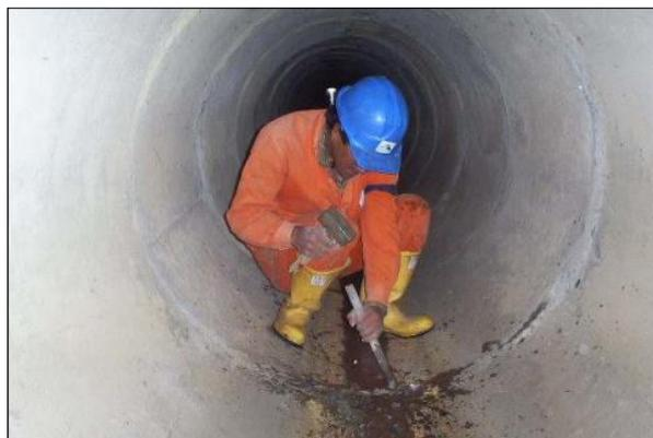
**Ilustración 12 Sellado de anillos en tubería**
