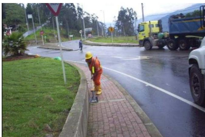
**Ilustración 10 Mantenimiento rutinario, limpieza de cunetas y bermas**
