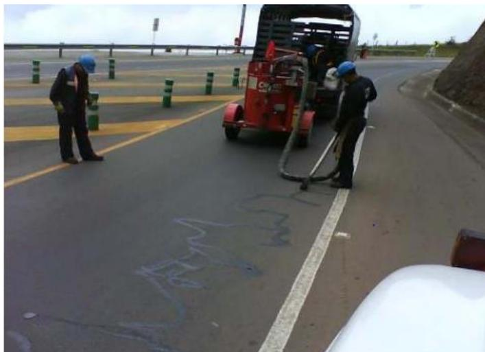
**Ilustración 14 Mantenimiento rutinario, sello de grietas en el pavimento**
