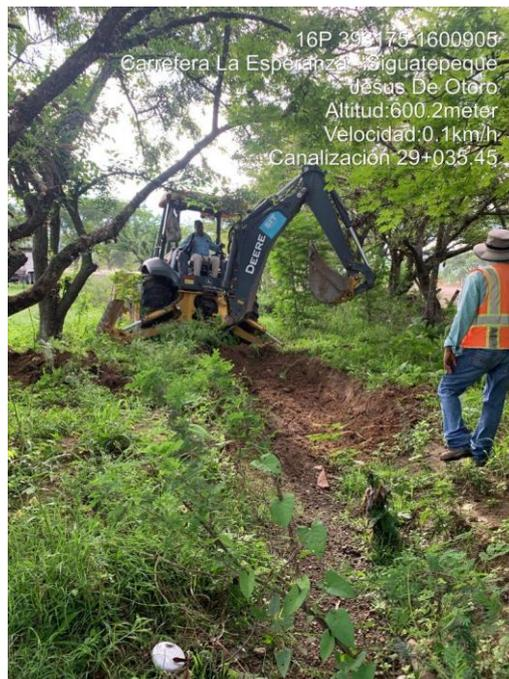
**Ilustración 72 Canalización tubería de salida en alcantarilla 29+030**
