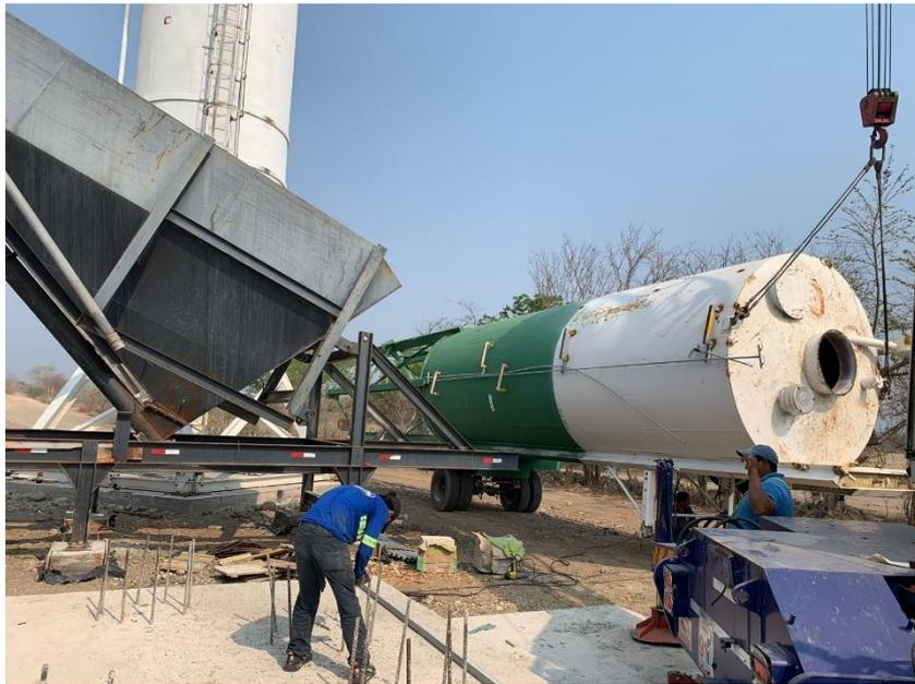
**Ilustración 33 Colocación de silo**
