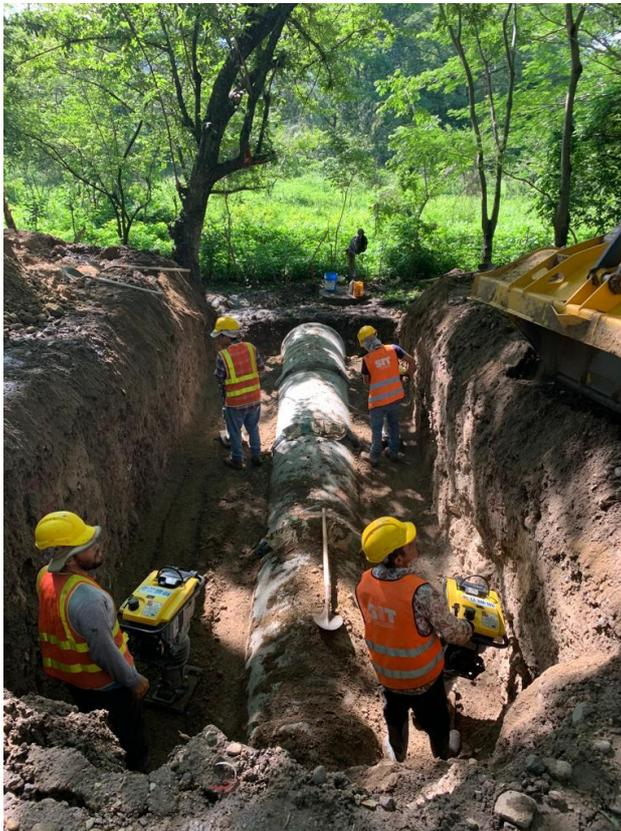
**Ilustración 88 Cierre de alcantarilla ubicada en la estación 27+931.80**
