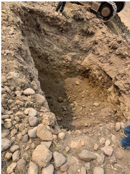
**Ilustración 31 Excavación de fosa séptica**
