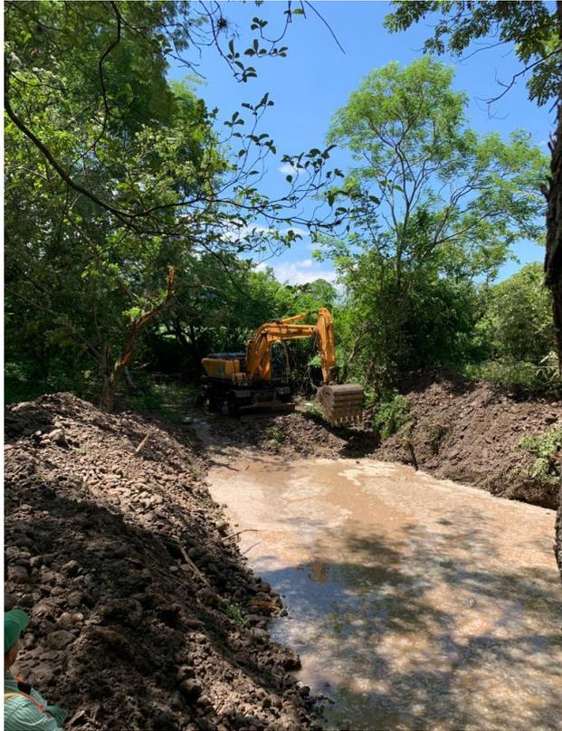
**Ilustración 87 Canalización de quebrada**
