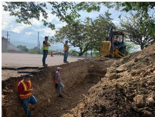
**Ilustración 66 Excavación para alcantarilla 28+908**
