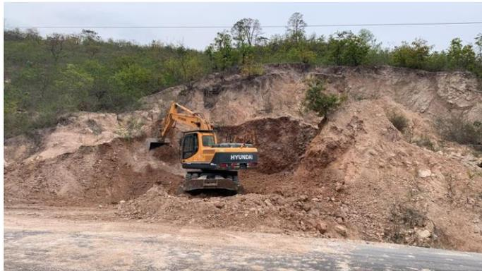
**Ilustración 62 Remoción y acarreo de material de derrumbe**
