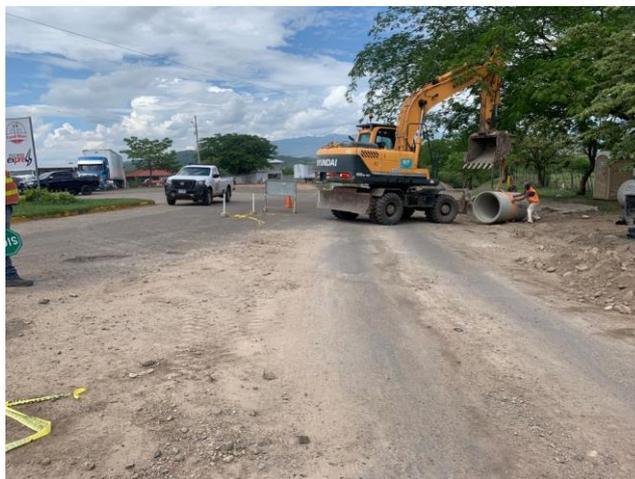
**Ilustración 68 Colocación de tubos en alcantarilla 29+060**
