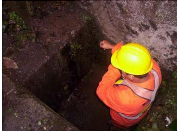
**Ilustración 11 Limpieza de alcantarilla**
