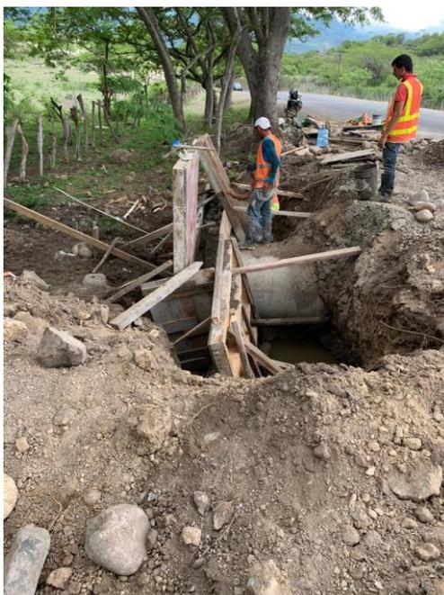
**Ilustración 73 Encofrado para cabezal en alcantarilla de salida estación 31+533**
