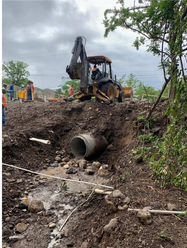
**Ilustración 80 Limpieza en el tubo de salida para encofrado de cabezal**
