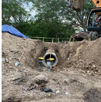
**Ilustración 65 Compactación de material sobre alcantarilla**
