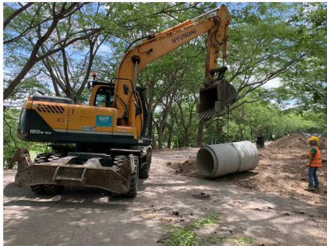
**Ilustración 86 Colocación de tubería en alcantarilla ubicada en estación 27+931.80**
