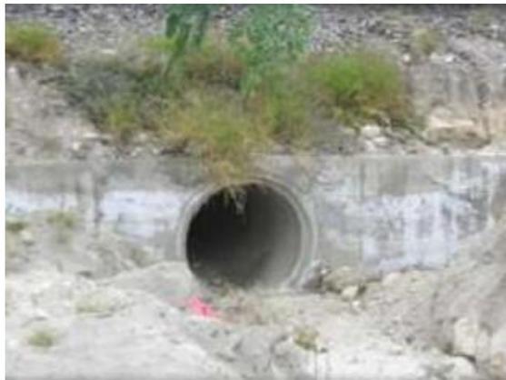
**Ilustración 17 Drenaje transversal, tubo de concreto reforzado**
