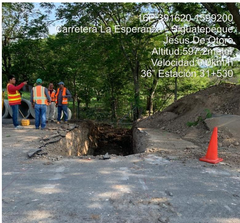
**Ilustración 64 Apertura de zanja estación 31+533**
