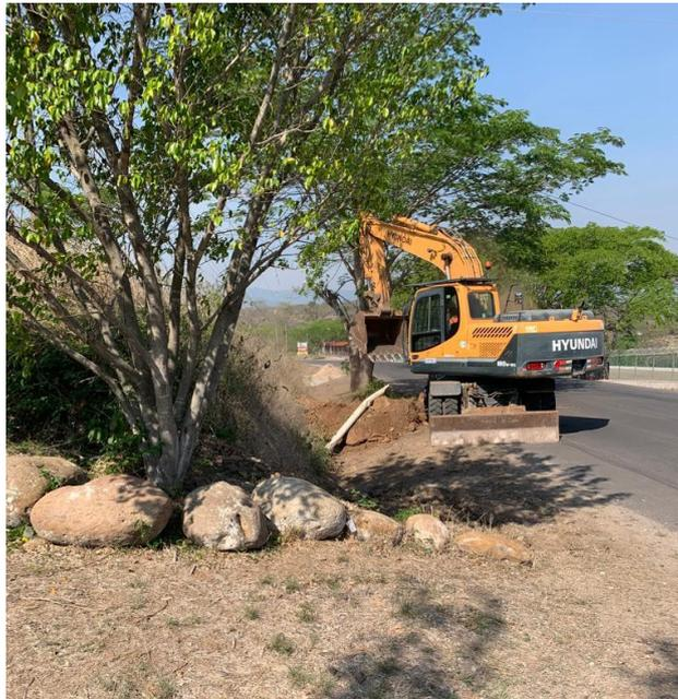
**Ilustración 51 Excavadora realizando limpieza en accesos**
