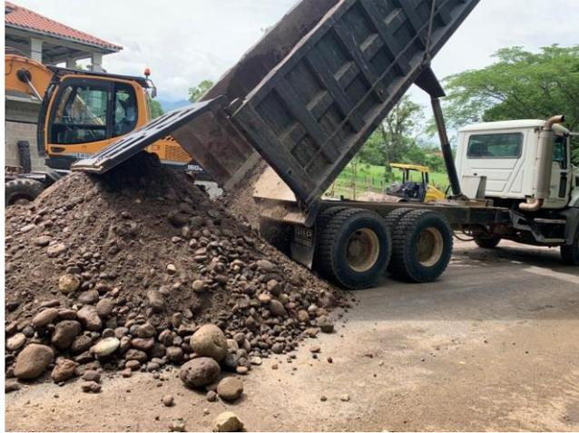
**Ilustración 85 Material de río para filtro en alcantarilla**
