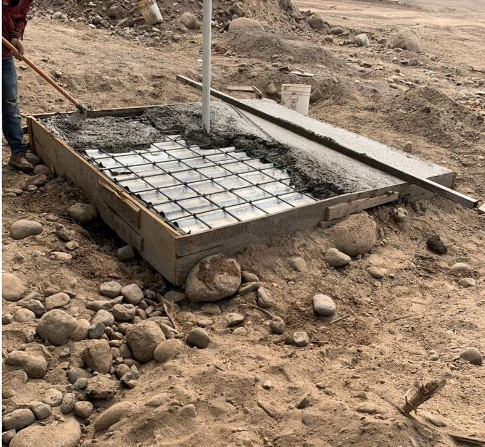
**Ilustración 35 Fundición de losa superior tanque de almacenamiento de agua**
