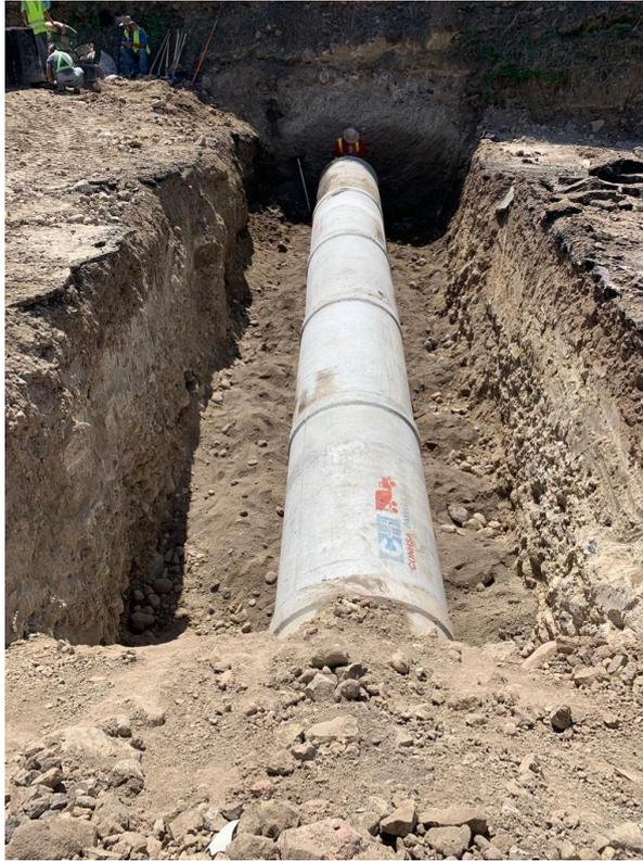
**Ilustración 71 Alcantarilla de entrada 36 pulgadas de diámetro estación 30+408**
