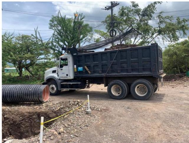
**Ilustración 77 Material de río para primera capa de compactación**
