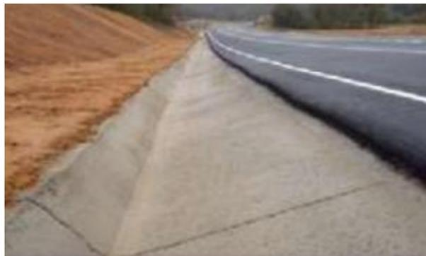
**Ilustración 16 Drenaje longitudinal triangular**
