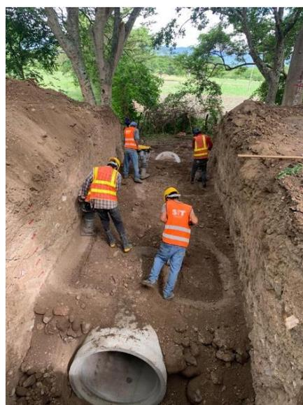
**Ilustración 84 Aterrado de alcantarilla de salida estación 28+038.76**
