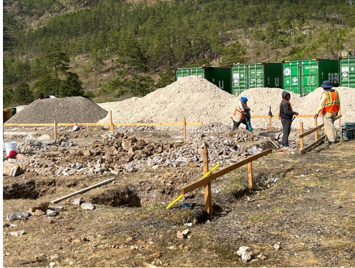
Ilustración 25- Conformación del suelo de apoyo en la zona de Zambrano
