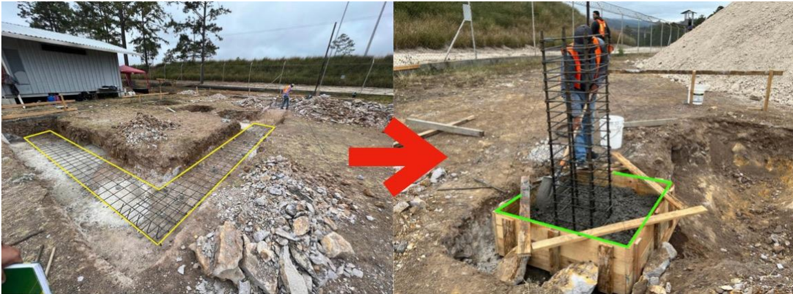
Ilustración 28- Fundición de la cimentación del almacén en la zona de Zambrano
