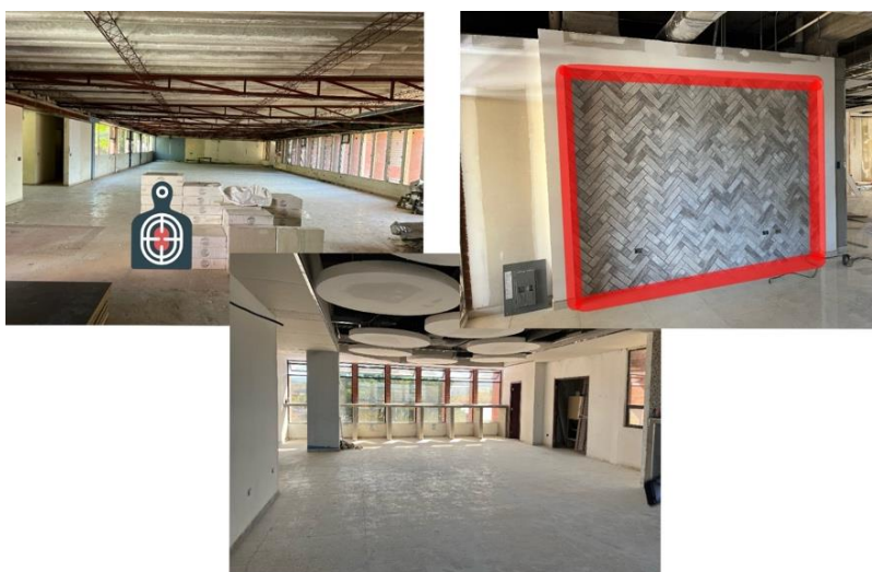
Ilustración 15- Avances de remodelación interna de la edificación en colonia La Godoy
