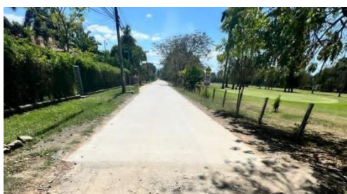
Ilustración 7-Sistema rehabilitación mediante whitetopping en La Lima
