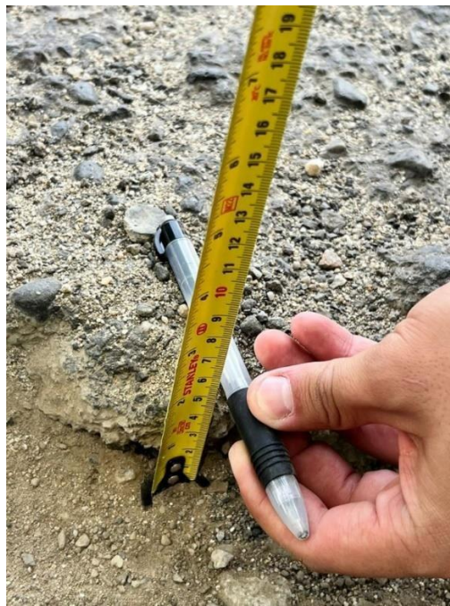
Ilustración 139-Medición de espesor sobrante de la carpeta asfáltica
