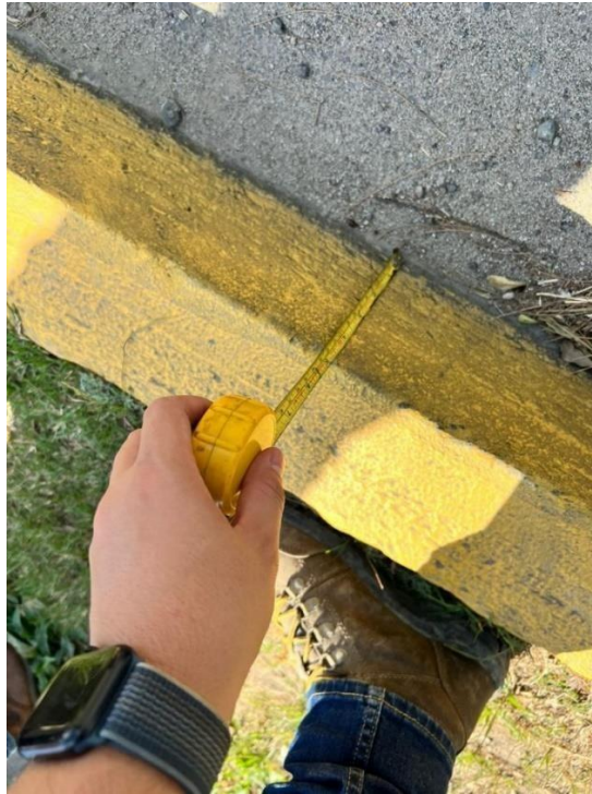
Ilustración 128- Medición de la geometría del pavimento existente
