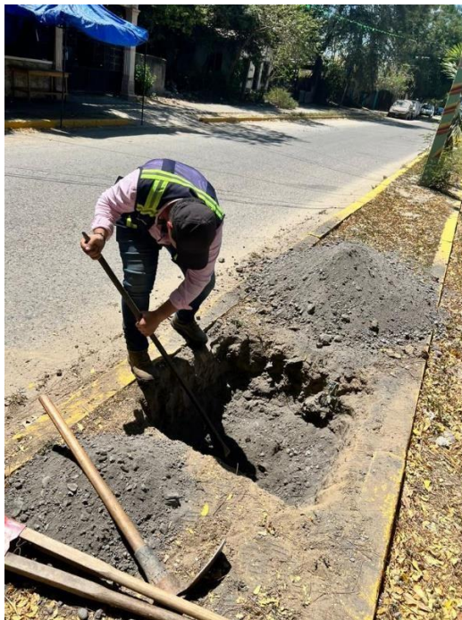
Ilustración 133-Profundizando la calicata
