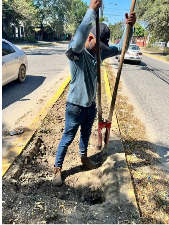
Ilustración 132 -Excavación de calicata
