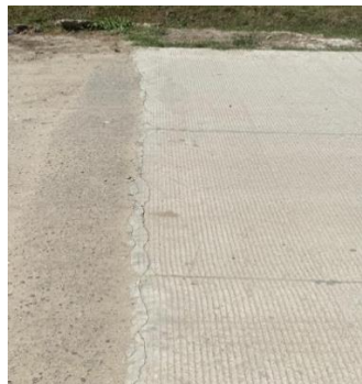
Ilustración9-Sistema de whitetopping en la Lima
