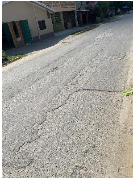
Ilustración 1- Parcheo Bulevar Fuerzas Armadas
