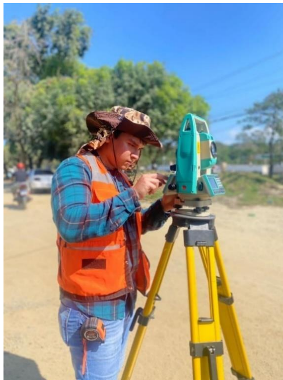
Ilustración 88-Usa del equipo topográfico
