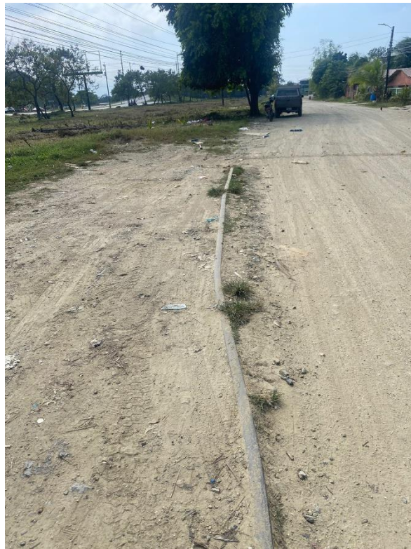
Ilustración 84-Línea del ferrocarril en la zona
