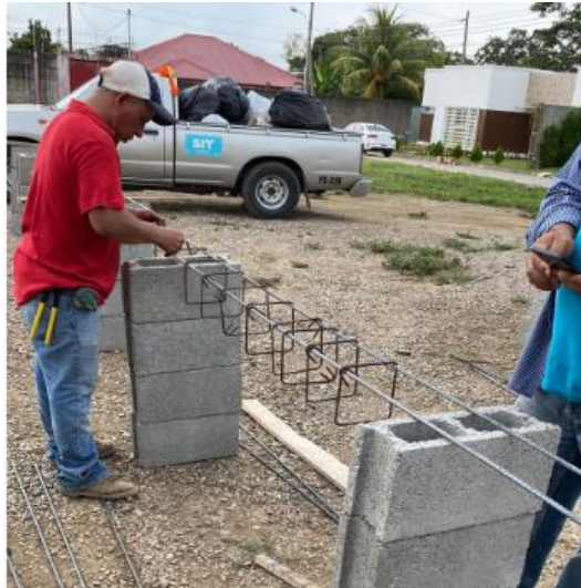
Ilustración 52 - Armado de hierro con 4 varillas de 3/8" y anillos @0.15m de varilla #2
