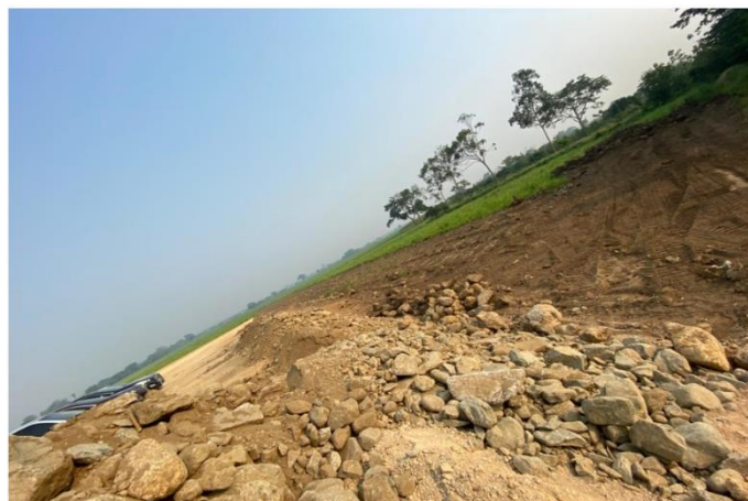
Ilustración 8 - Proyecto Gasolinera Texaco City
