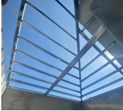
Ilustración 27 - Canaletas instaladas entre cajones metálicos
