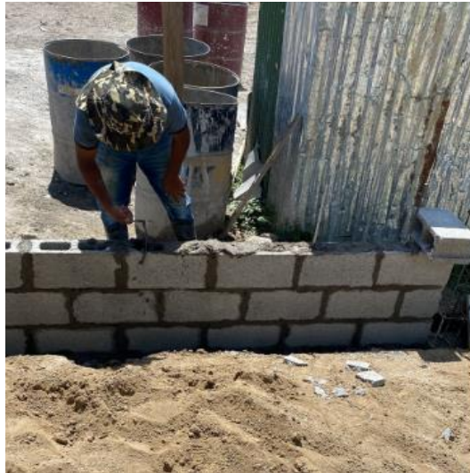
Ilustración 54 - Albañil pegando bloques con mortero de relación de cemento y arena 1:4
