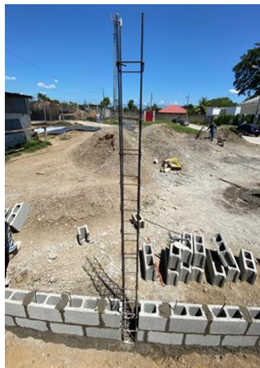
Ilustración 42 - Castillo de 4 varillas #3 y anillos #2 a cada 25cm
