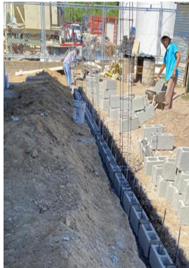
Ilustración 41 - Muro de concreto con bloques de 6"
