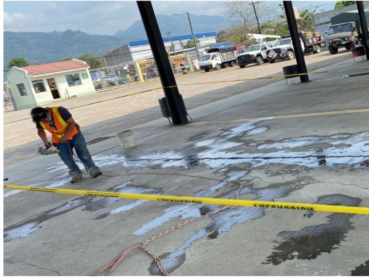
Ilustración 9 - Reparación de losa de concreto en el taller de Cordon's
