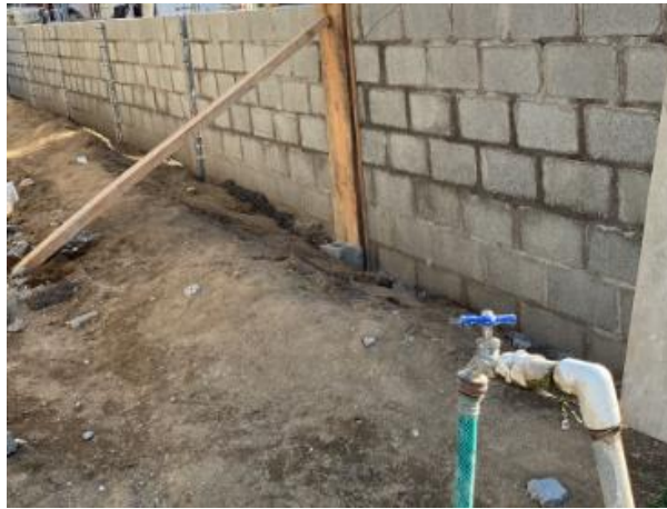
Ilustración 44 - Hiladas de bloques del muro
