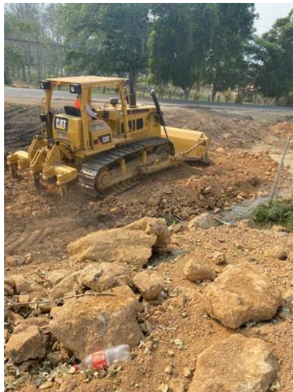
Ilustración 10 - Nivelación a nivel de la carretera de terracería
