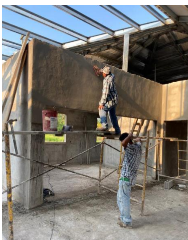
Ilustración 40 - Albañil puliendo pared, arriba de un andamio
