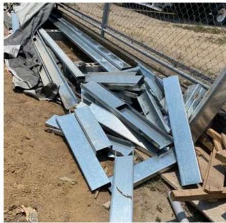
Ilustración 28 - Desperdicios de las canaletas 2"x6"x1/16"
