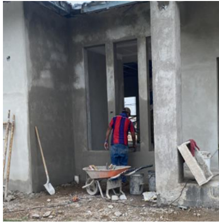
Ilustración 47 - Albañil puliendo boquetes de ventanas
