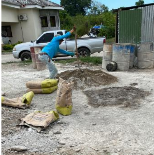
Ilustración 50 - Cuarteo de concreto con arena gruesa y cemento de relación 1:5
