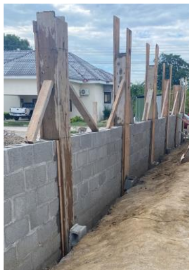
Ilustración 43 - Encofrado de castillos
