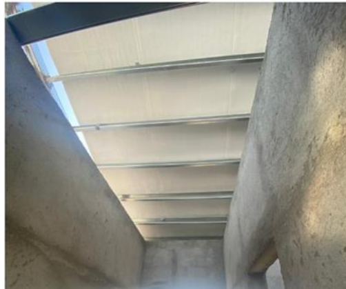
Ilustración 29 - Instalación de aislante térmico
