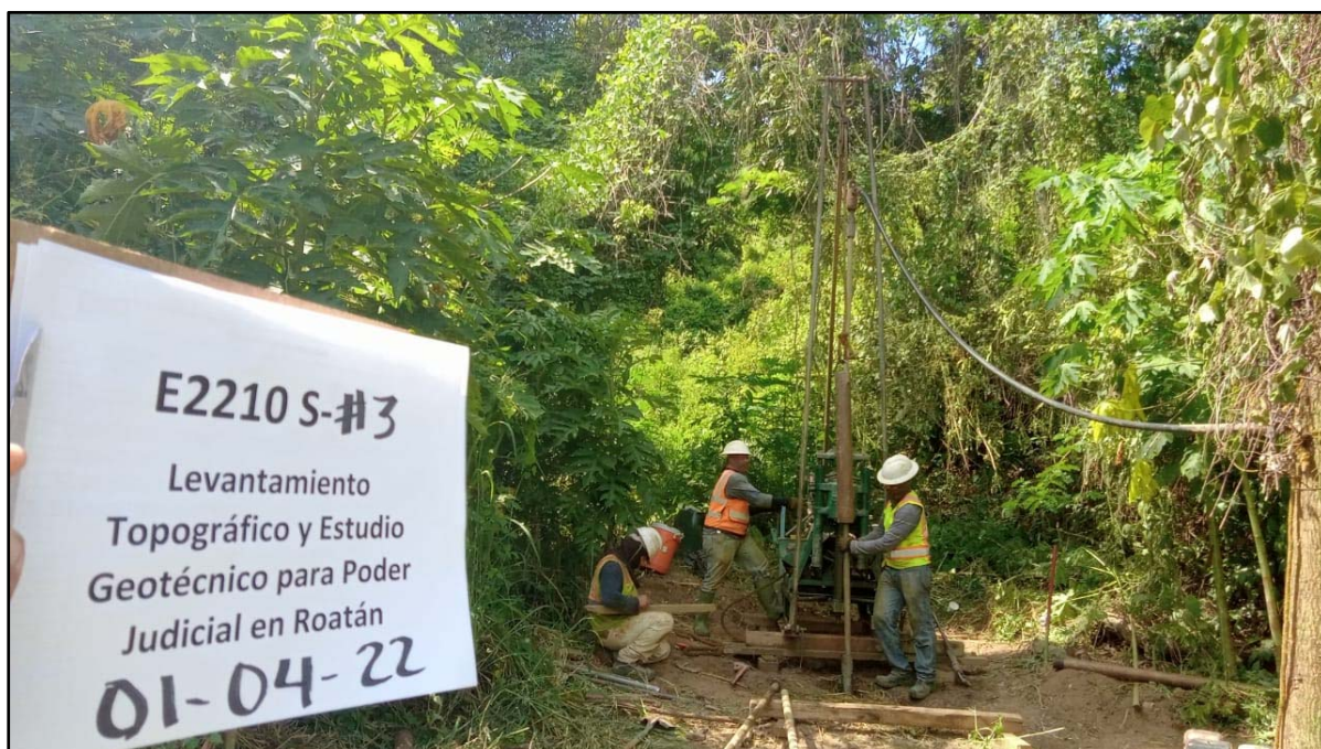
Anexo 2- Estudio Geotécnico en Municipio de Roatán, Islas de la Bahía.
