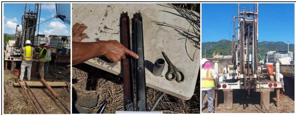
Ilustración 4- Extracción de muestras mediante el SPT
