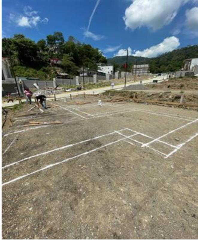
**Ilustración 15-Marcación de zapatas para excavación**
