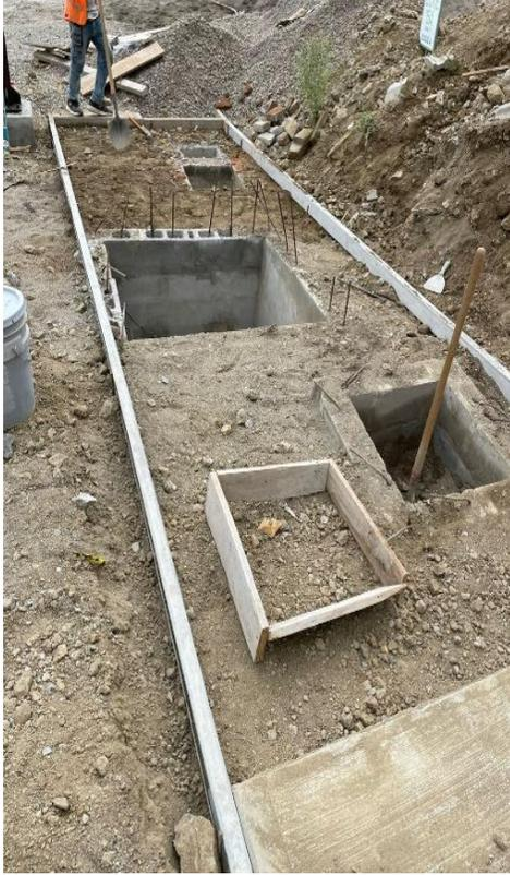
**Ilustración 18-Revisión de cajas de registro**
