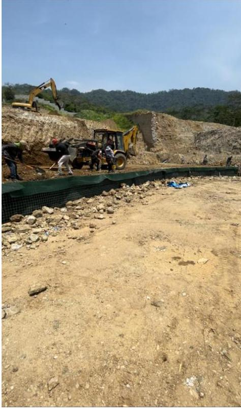
**Ilustración 13-Maquinaria trabajando en la excavación de ampliaciones en la urbanización.**
