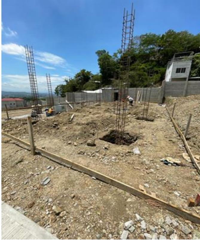
**Ilustración 16-Nivelación de columnas para fundición**
