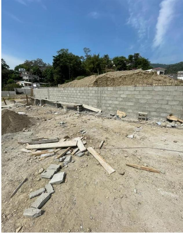
**Ilustración 11-Levantamiento de muro delimitante de 8 hiladas con varilla @ 2 hiladas fundidos**
