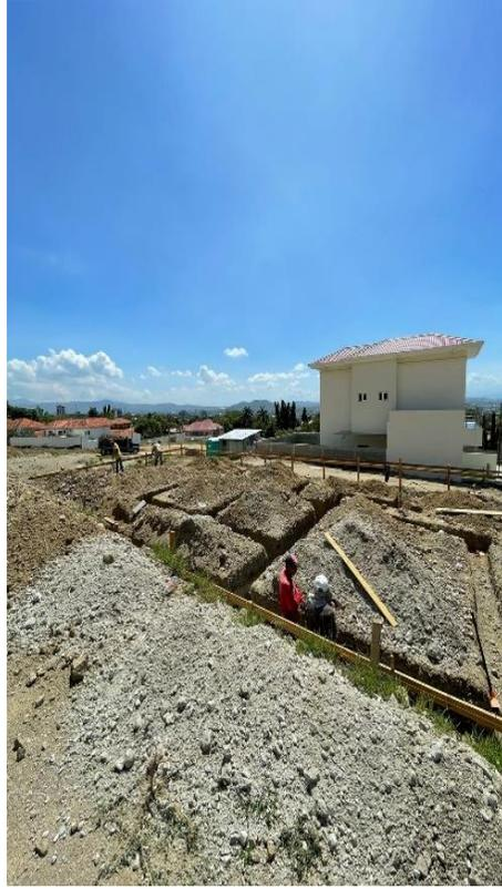
**Ilustración 17-Excavación terminada para cimentación**
