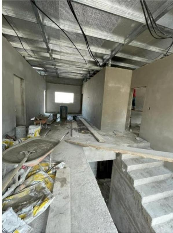
**Ilustración 2- Inspección de segundo nivel de casa previo a pulir las zonas repelladas**
