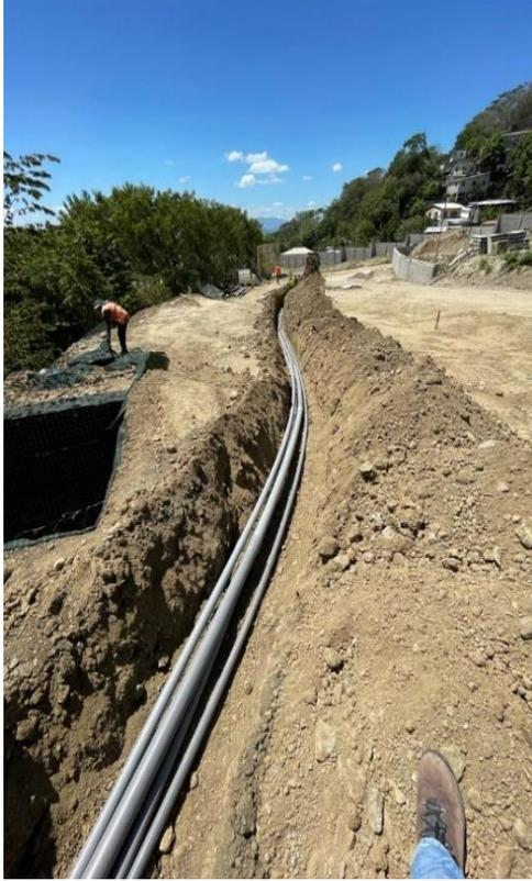
**Ilustración 14-Instalación de tubería Conduit para sistemas eléctricos**
