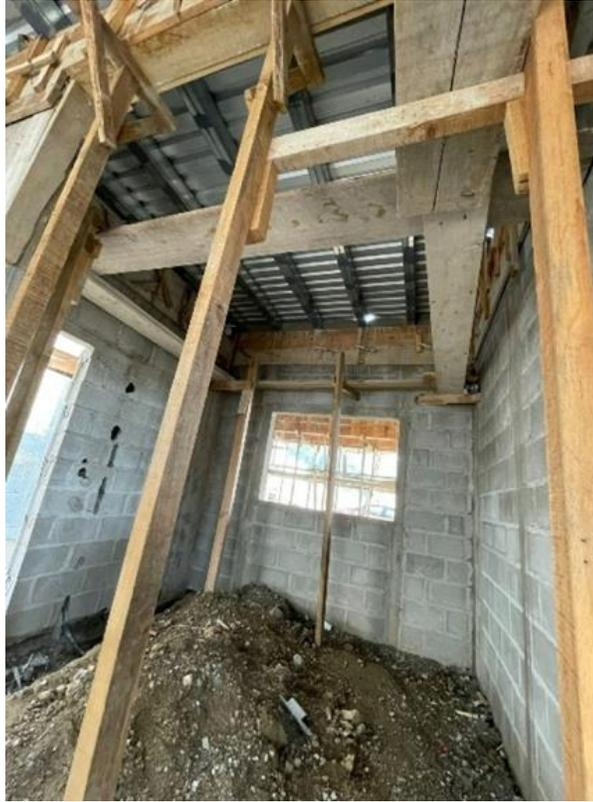
**Ilustración 6-Piloteado de la losa de entrepiso**
