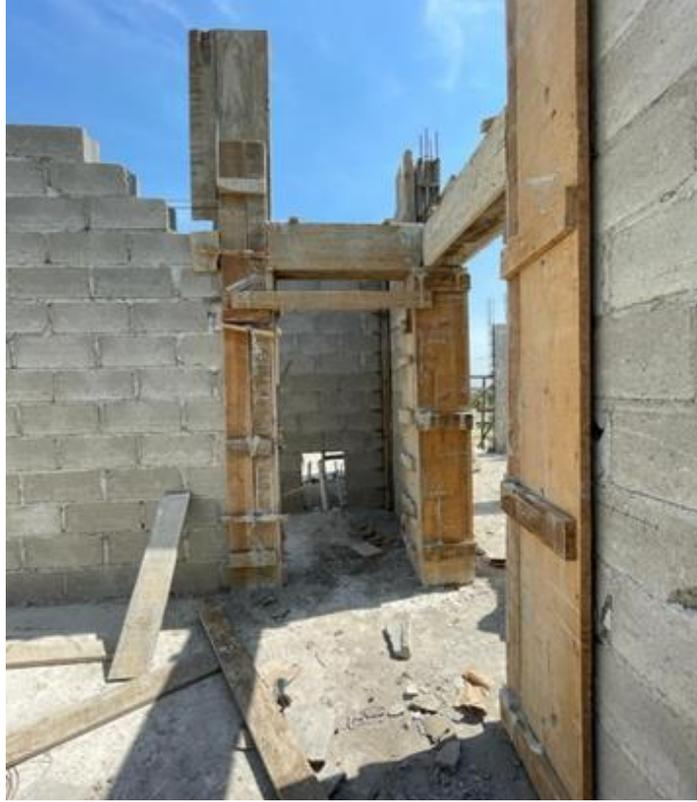
**Ilustración 9-Encofrado de boquetes de puerta y solera aérea**
