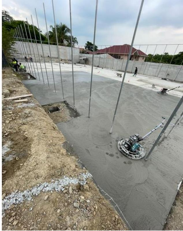
**Ilustración 10-Fundición de piso de acabado allanado**
