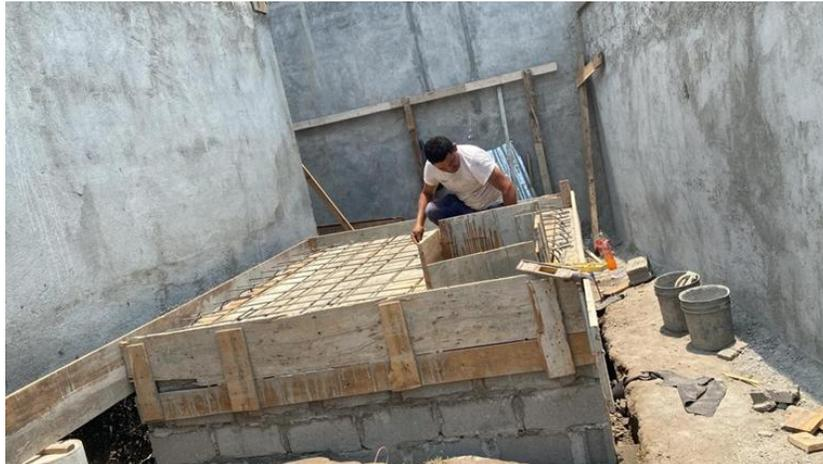
**Ilustración 5-Encofrado de cisterna**
