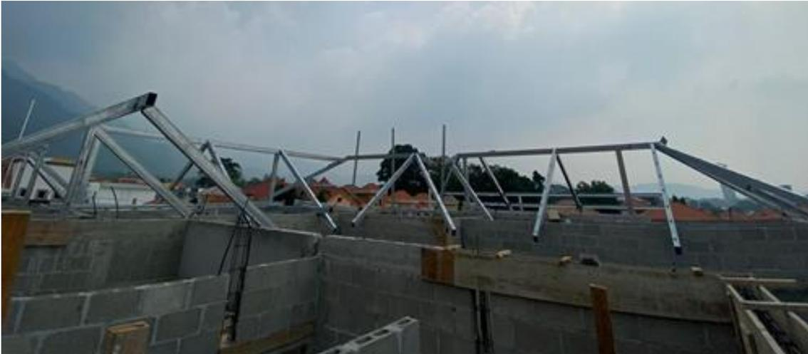
**Ilustración 10-Colocación de estructura de techo.**
