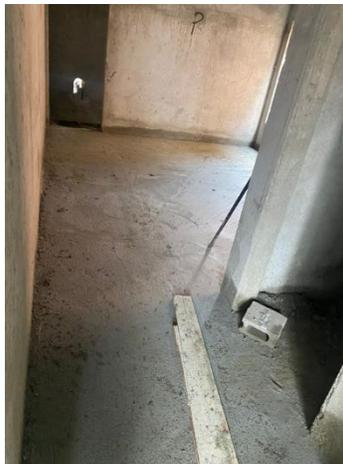
**Ilustración 9-Fundición de firme de cuarto de primer nivel.**
