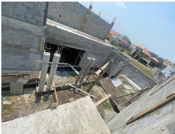
**Ilustración 7- Fundición de vigas decoradas.**
