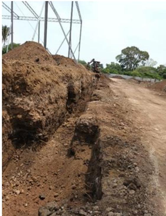
**Ilustración 65- Excavación Zapata Corrida Banda Lateral N3**
