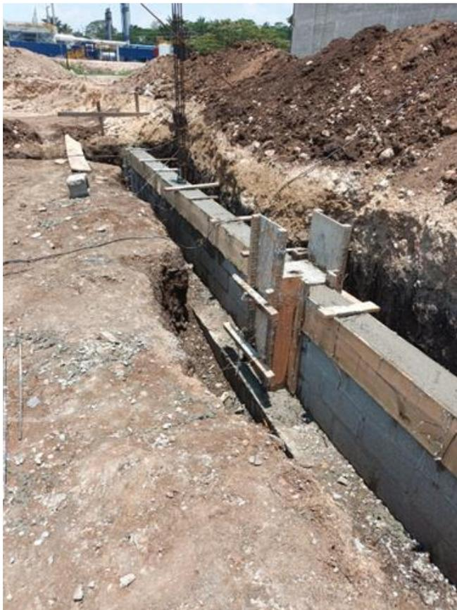
**Ilustración 48- Fundición de soleras, pedestales y colocación de placas N3**
