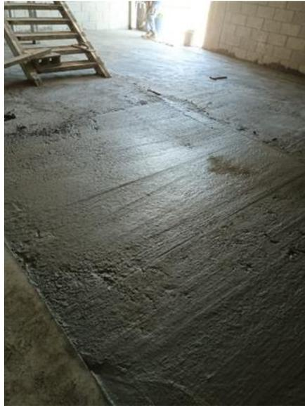
**Ilustración 52-Fundición de firme de concreto Oficinas Nave 2**
