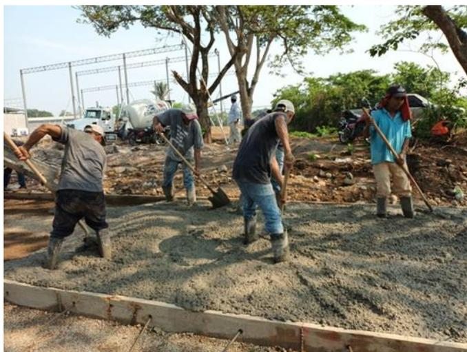
**Ilustración 37- Fundición de pavimentos exteriores**
