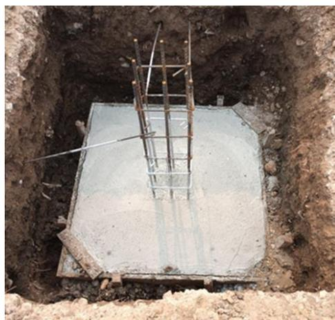
**Ilustración 31- Zapatas Aisladas Z-2 Nave 3**
