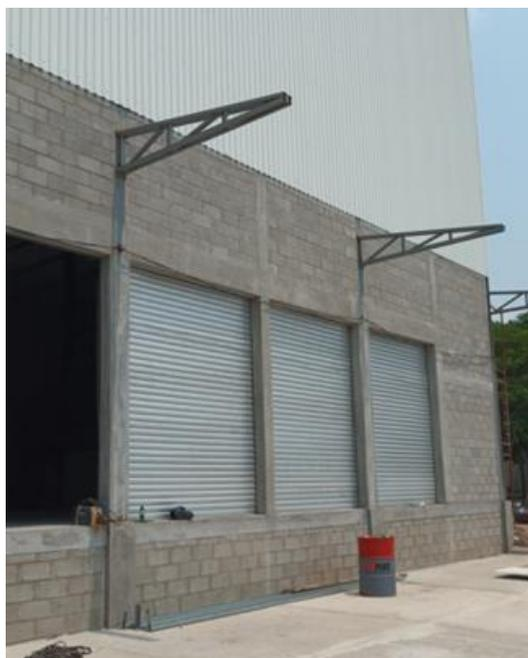
**Ilustración 33-Montaje de 8 armaduras en andenes de Nave 1**
