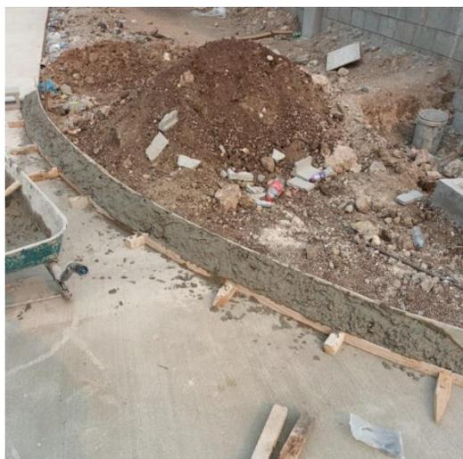
**Ilustración 38-Fundición de bordillos en pavimentos exteriores**
