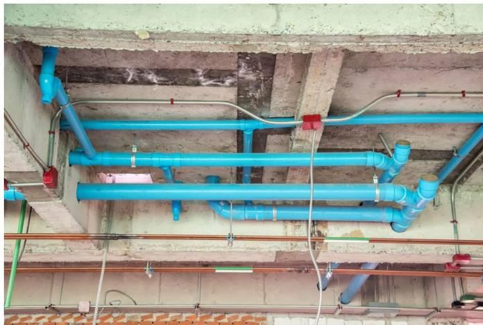
**Figura 44.** Sistema de Agua Potable Tuberías, *El Universo El Mayor Diario Nacional*, 2016. C.A. El Universo. [Imagen].
