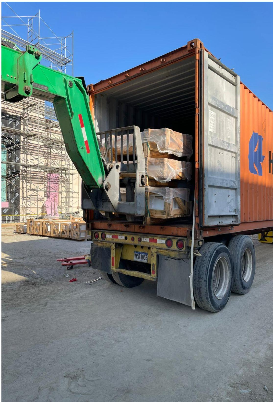
*Ilustración 5:* Equipo de telehandler utilizado para la descarga de pallets.
