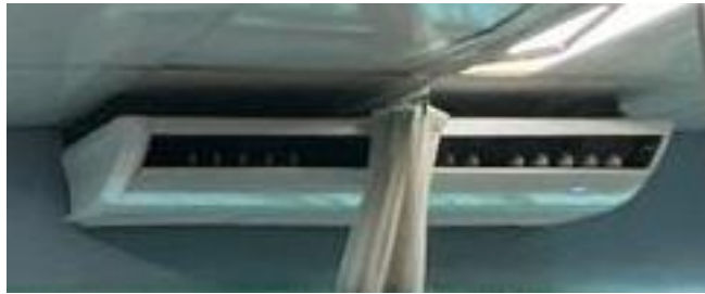
Ilustración 27. Mini-Split con capacidad de 60,000 BTU/h en Emergencia/Observación.
