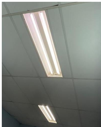
Ilustración 48. Iluminación led tipo tubo
