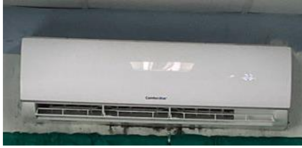
Ilustración 26. Mini-Split con capacidad de 12,000 BTU/h en triaje.
