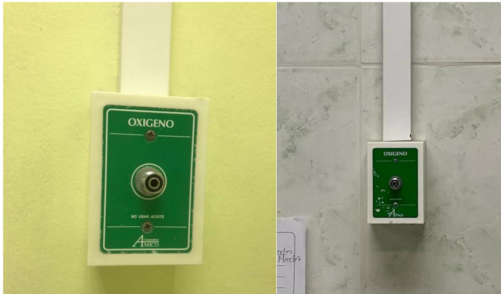
Ilustración 53. Toma de pared tipo DISS
