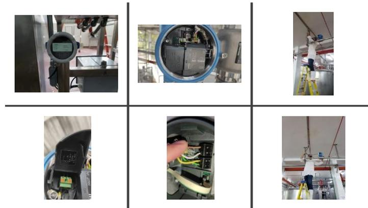
**Ilustración 11 Instalación y Configuración de Flujómetro**
